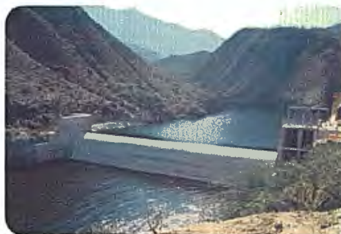
Fotografía 1. Presa derivadora del Sistema Acueducto II Querétaro
