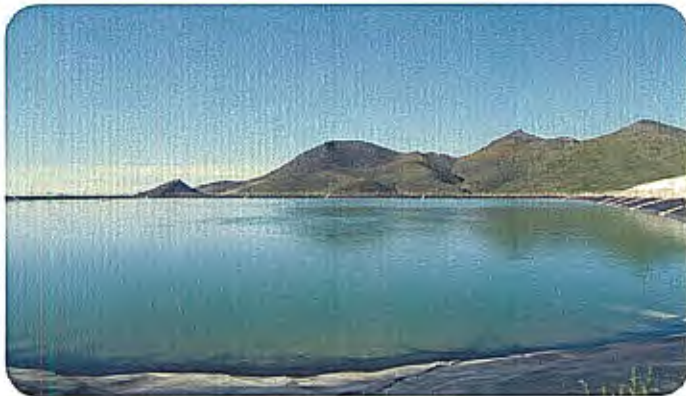
Fotografía 4. Bordo de seguridad
