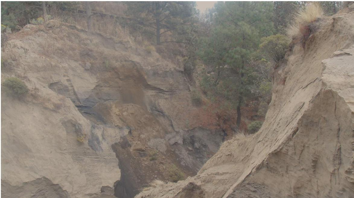
**Figura 4. Deslizamiento en donde se puede observar los diferentes tipos de materiales y la falta de cohesión. Fuente: Captura propia.**
