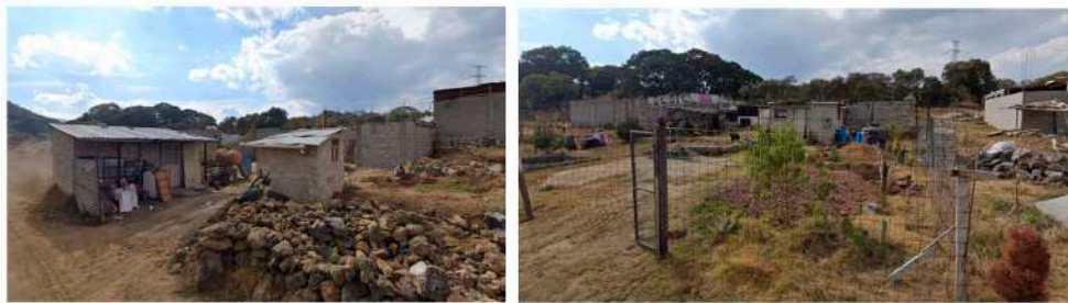
Imagen 108: Viviendas calle Brecha de las Torres de Santa Cecilia Tepetlapa, Xochimilco. Manzana 22 Fuente: Google Maps, 2019
