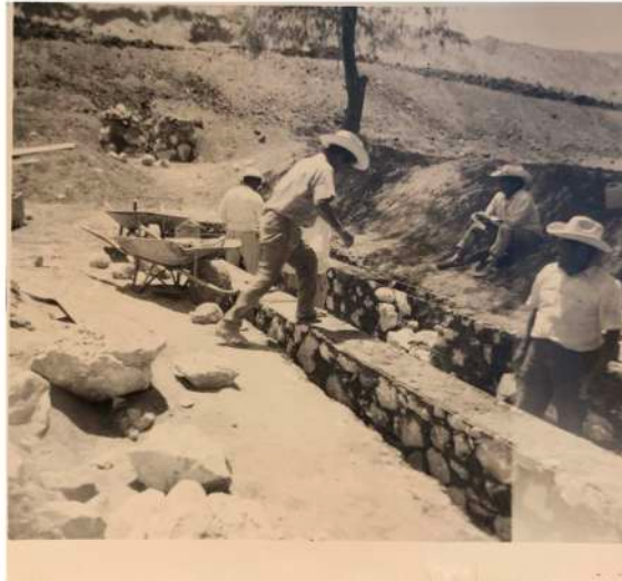
Imagen 57: "Construcción de los lavaderos"
