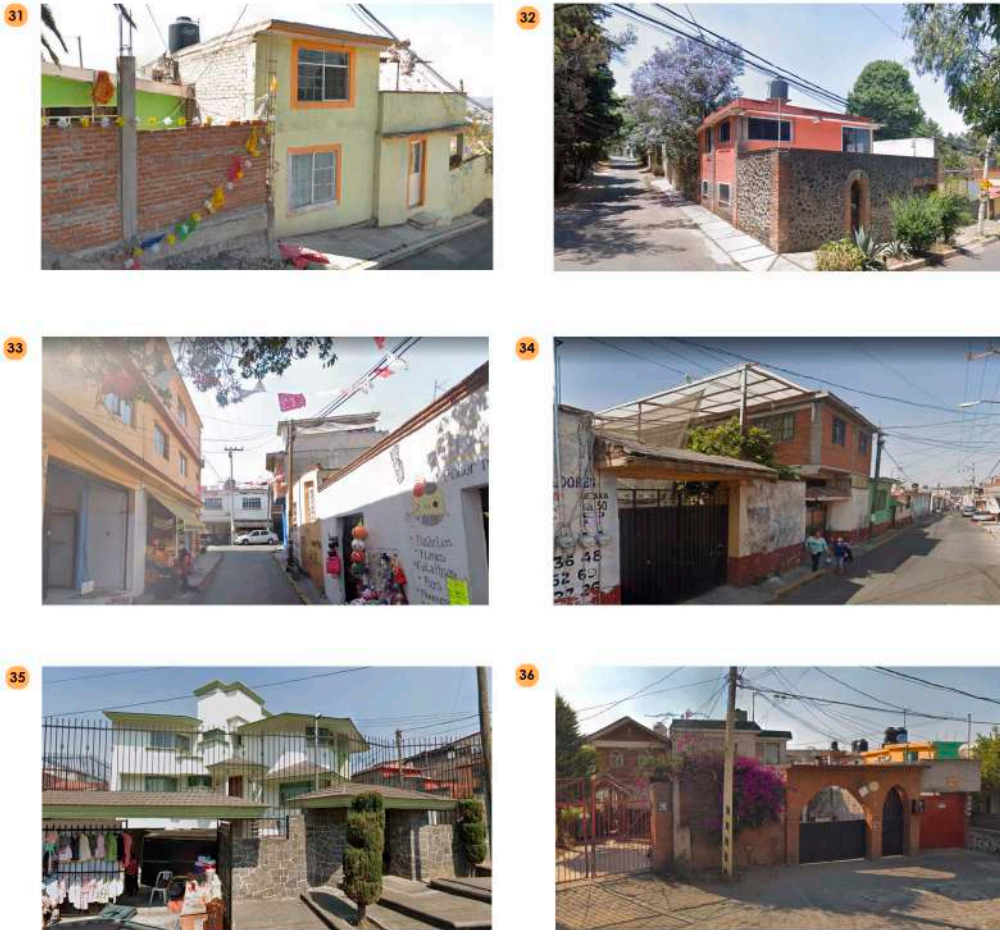
Imagen 123: Viviendas de materiales industrializados en etapa de acabados de Santa Cecilia Tepetlapa, Xochimilco Fuente: Google Maps, 2019
