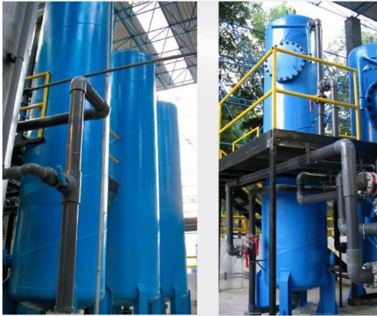
Figura 5.16. Unidades de filtración PP Cerro de la Estrella (IEMA, 2010)
