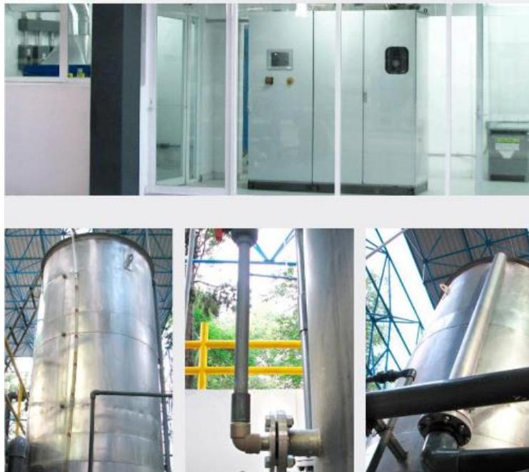
Figura 5.15. Generador de  $O_3$  y tanque de contacto con  $O_3$  PP Cerro de la Estrella (IEMA, 2010)
