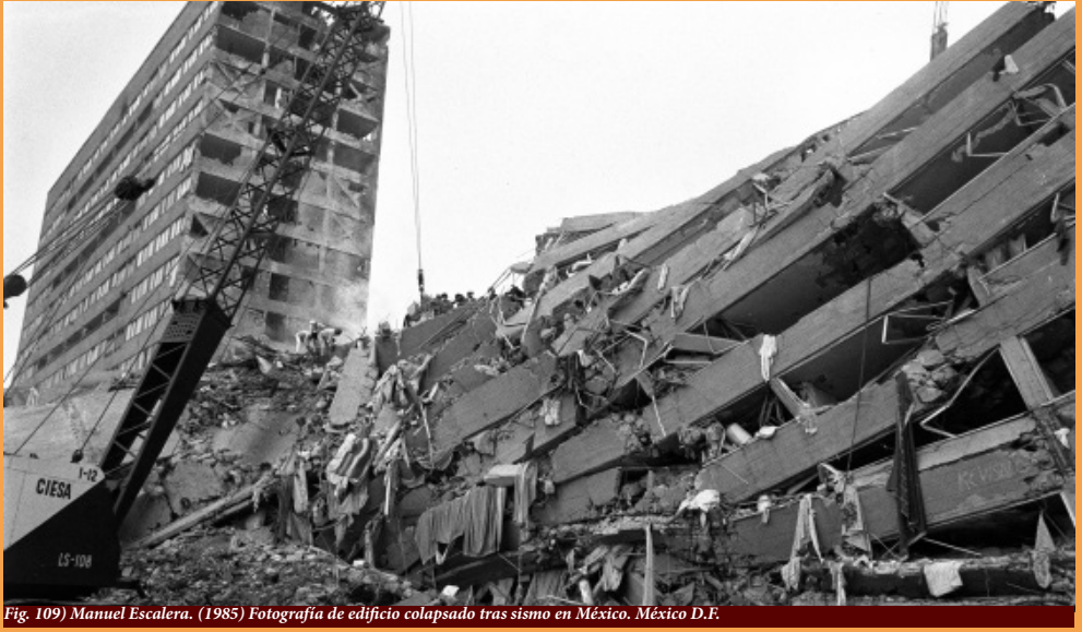
Fig. 109) Manuel Escalera. (1985) Fotografía de edificio colapsado tras sismo en México. México D.F.
