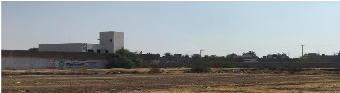
Vista de la colindancia oriente y colindancia sur, calle sin nombre .
