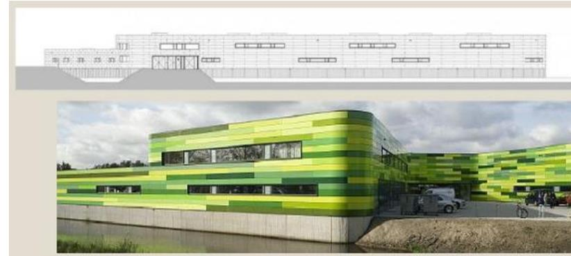
El revestimiento del refugio es de 1.5 mm de espesor de paneles de acero enchapados Sendzimir-cinc con una longitud máxima de 5.40 m Revestimiento en polvo en 12 tonalidades de verde que fluye a lo largo del edificio.<sup>6</sup>
