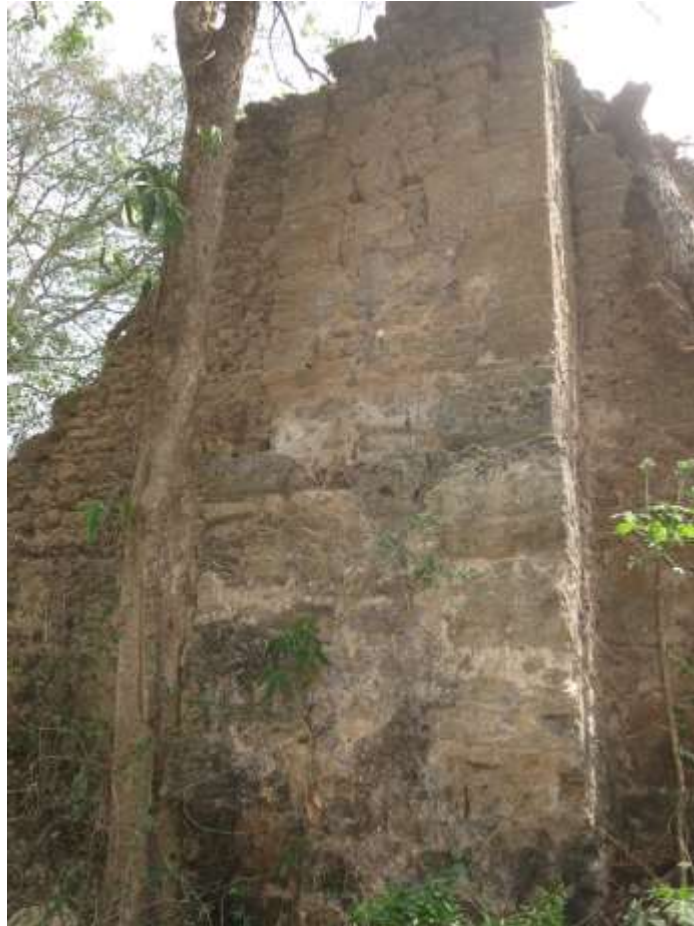
Figura 155. Acercamiento al muro principal
