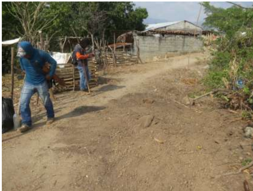
Figura 173. Área donde se trazó el pozo 4
