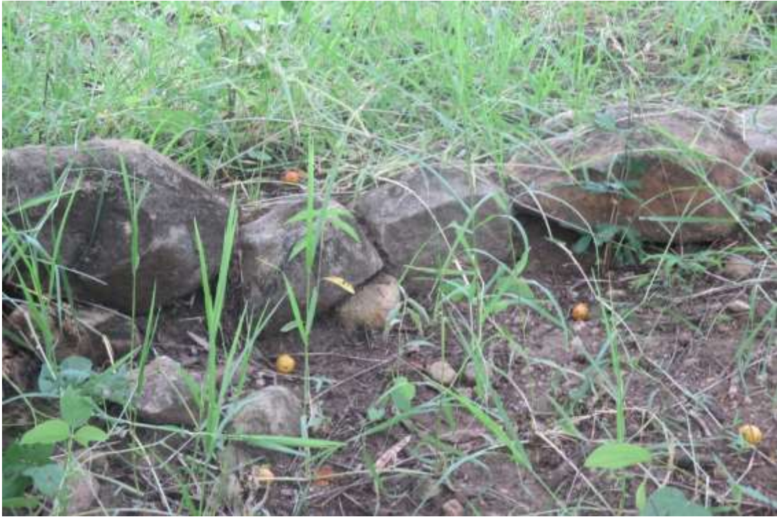
Figura 59. Otra vista del muro contrafuerte
