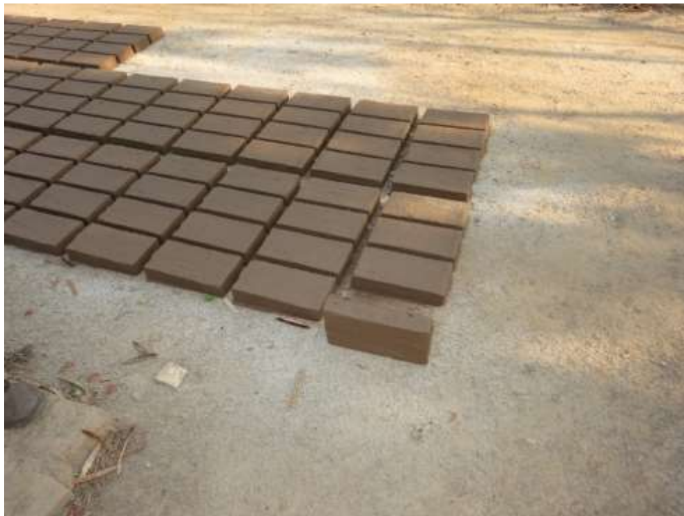
Figura 131. Acercamiento al área de moldeado y secado del molde de tabiques
