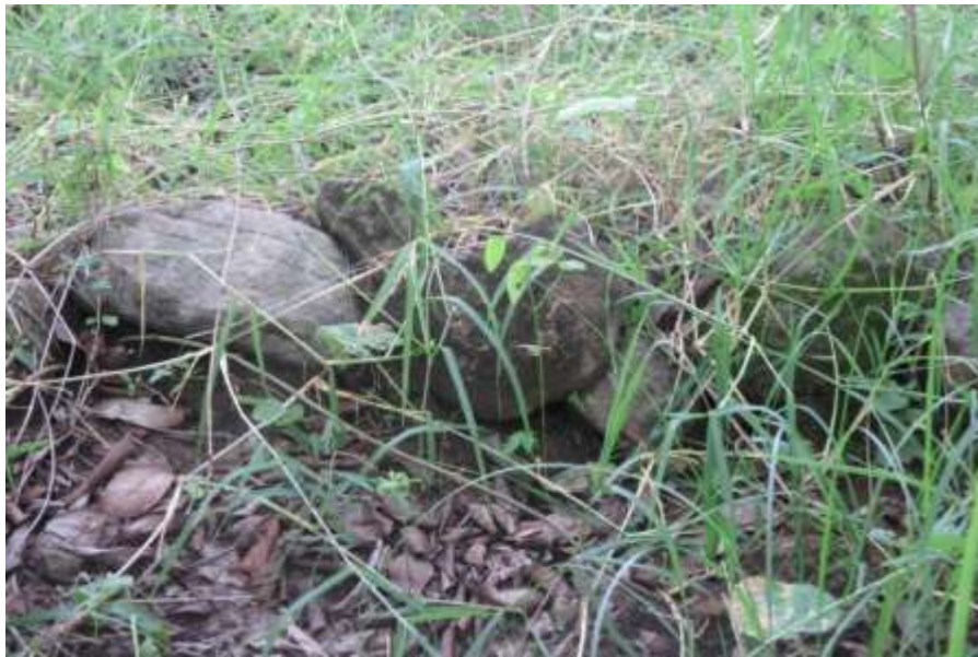
Figura 58. Vista del muro contrafuerte
