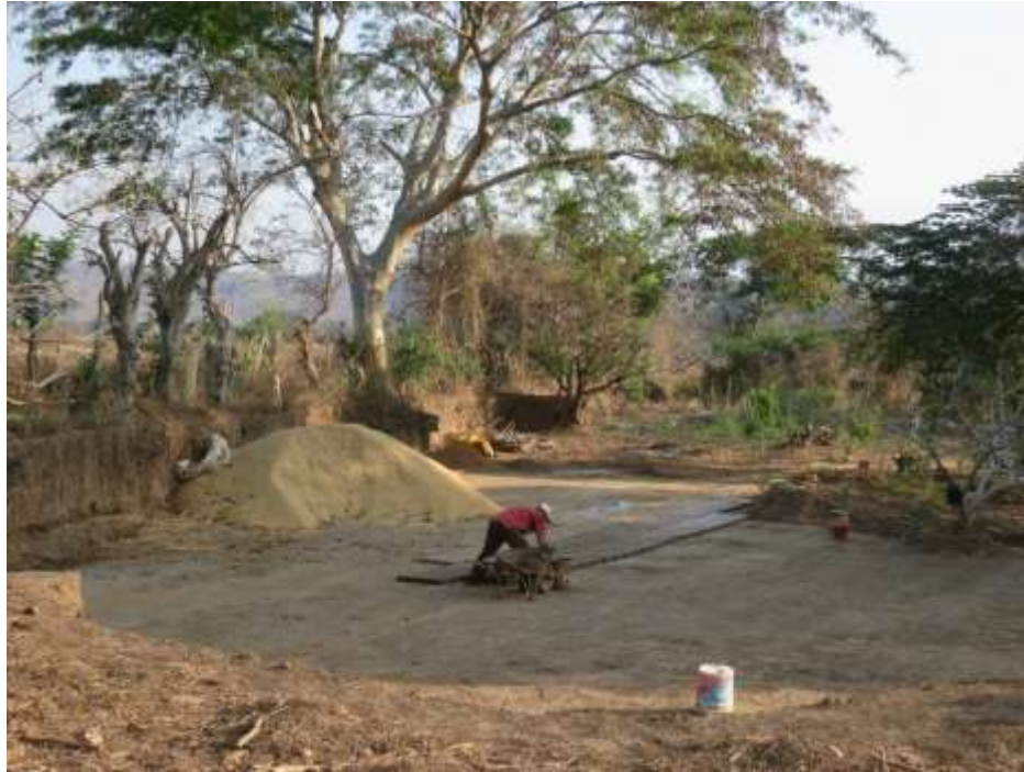
Figura 130. Llenado del molde para la elaboración de los tabiques
