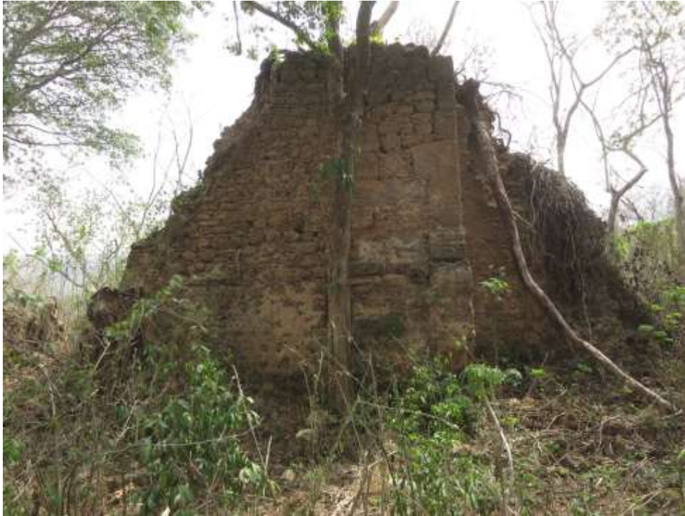
Figura 156. Acercamiento al muro principal
