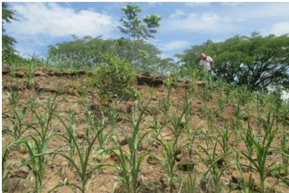
Figura 45. Vista de la estructura terraceada
