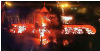
Imagen aérea del inmueble cuando el fuego consumía el interior en su totalidad.
