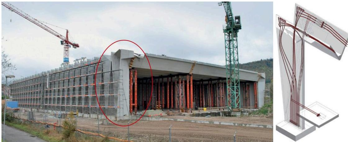
Observamos en la figura como se distribuye la densidad de acero y se concentra en los puntos de transmisión de momento en el sistema de marcos rígidos de concreto a través del cual se resuelve el edificio.
