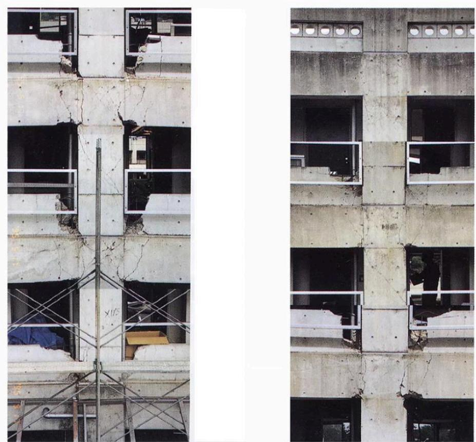
En la imagen observamos como la fractura se desarrollan en los puntos de continuidad estructural, lo que evidencia las concentraciones de esfuerzos y un diseño inadecuado.
