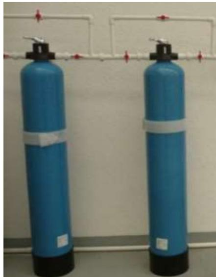
Figura 8. Filtro de lecho profundo y filtro de carbón activado (campus II)
