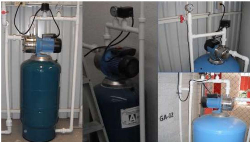
Figura 12. Bomba hidroneumática
