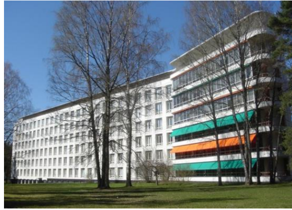
Imagen 10. Vista exterior del bloque de dormitorios
