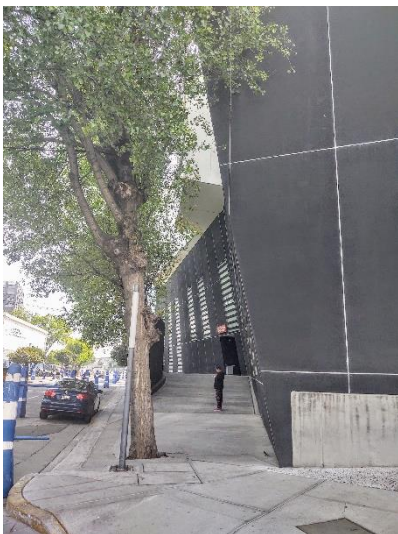
Imagen 4. Vista fachada poniente
