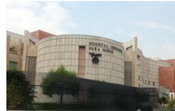
Foto no. 2. Fachada sureste
