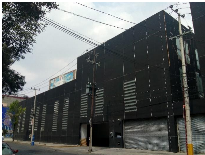
Imagen 5. Vista fachada oriente
