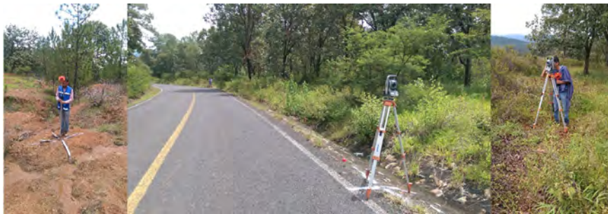
Figura 4.13: Levantamiento de los puntos de control con Estación Total y marcaje
