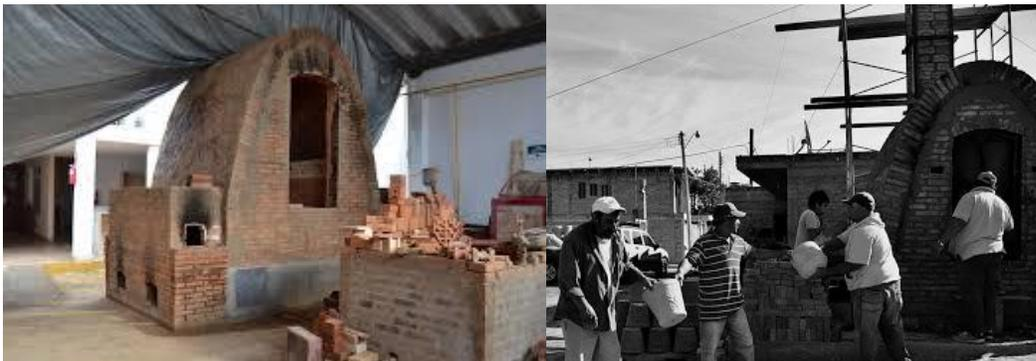
Figuras 2.2 y 2.3. Horno domestico para alfareria de barro y construcción del horno domestico<sup>b-c</sup>.
