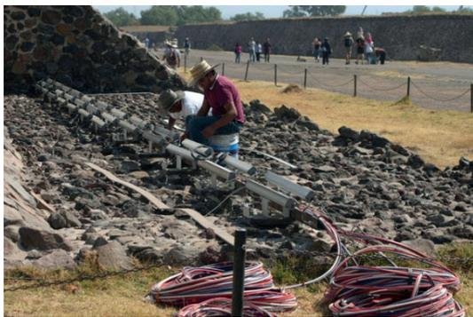
Imagen 31. Personal colocando luminarias e instalaciones en basamentos sobre Calzada Norte
