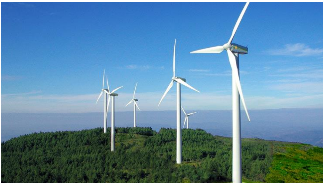
Figura 8. Central eólica en Serra do Burgo, Orense, España. Fuente Iberdrola, 2019.
