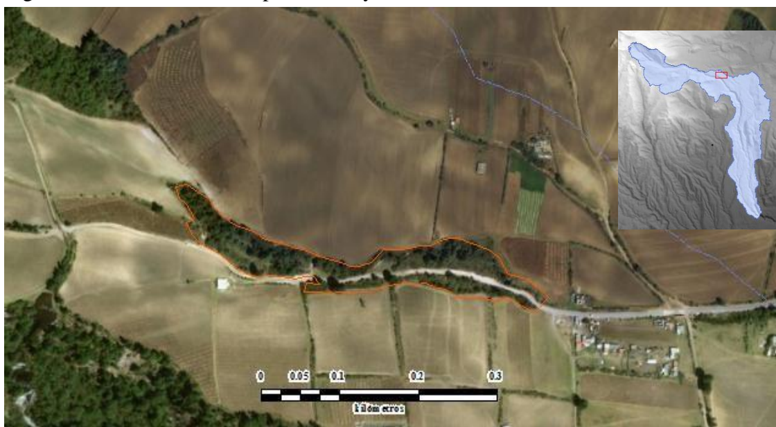
Fig.4.14. Barranco estabilizado en la cuenca media de la BAG.
