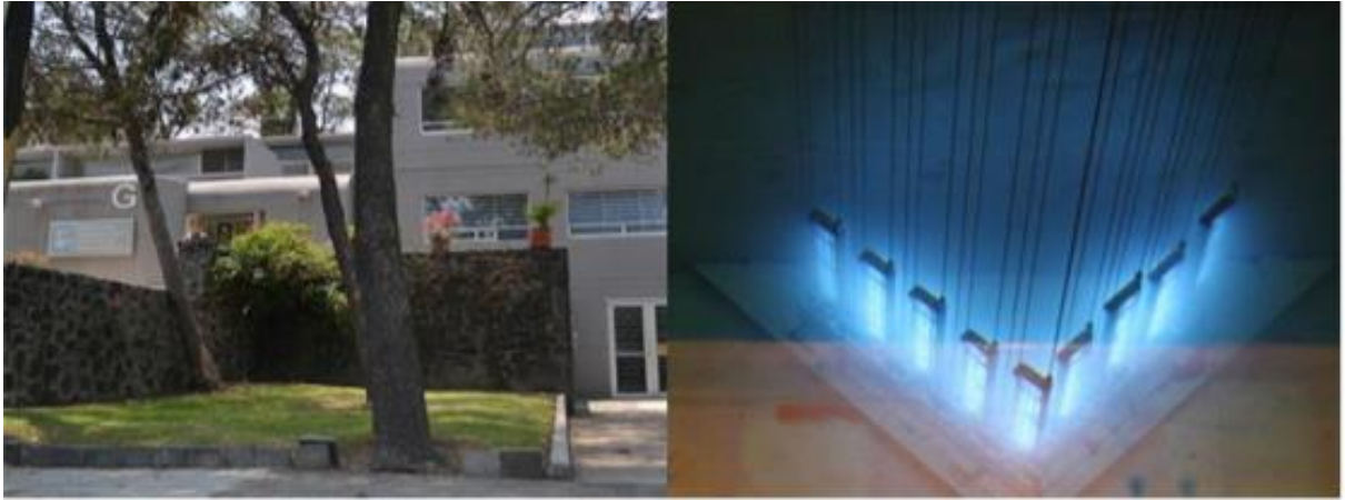
Ilustración 10. Irradiador del ICN, UNAM (izquierda). Lápices de ^{60}\text{Co} (derecha). (Audifred, 2019)
