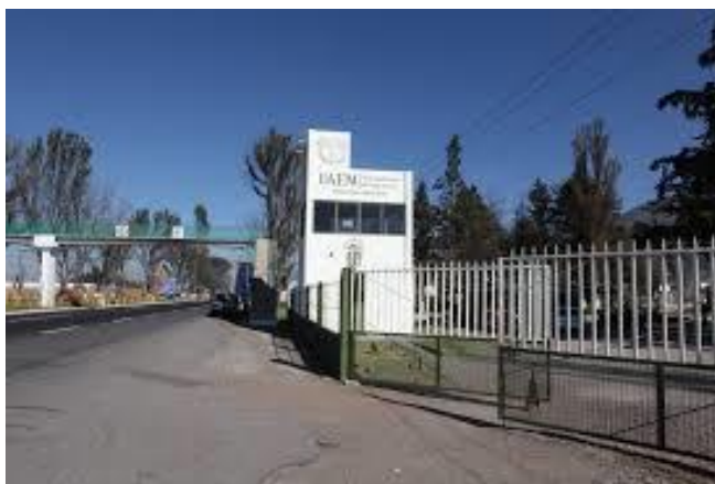
Entrada al plantel, a pie de la Autopista Toluca-Atlacomulco, Carretera Panamericana.
