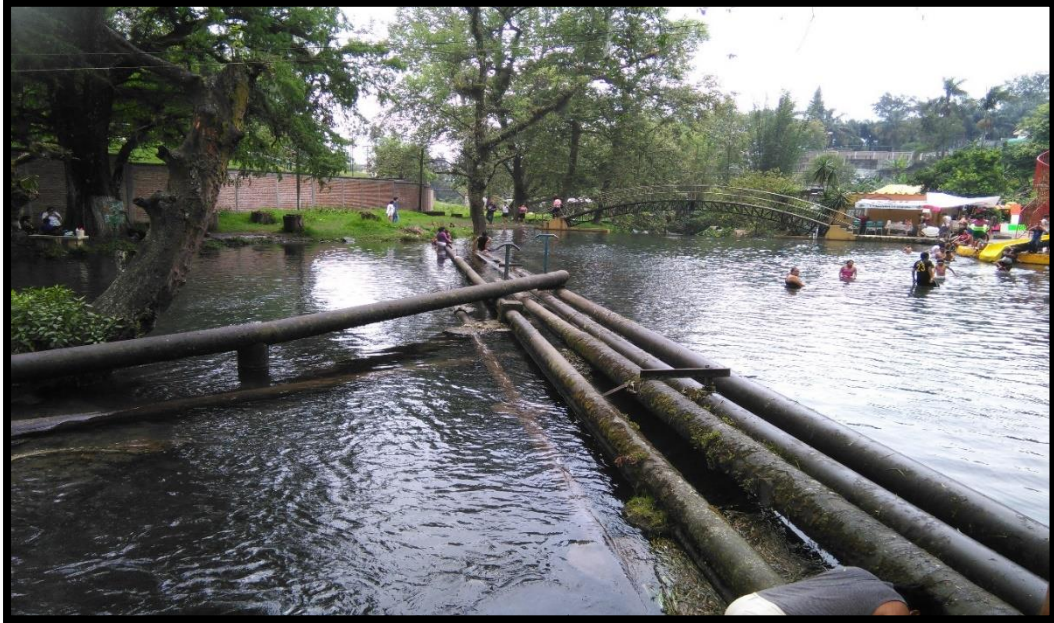
Figura 17. Entubamiento de parte de las aguas de "Ojo de Agua" para la distribución en la periferia del municipio. Foto tomada por Chávez, 2015.
