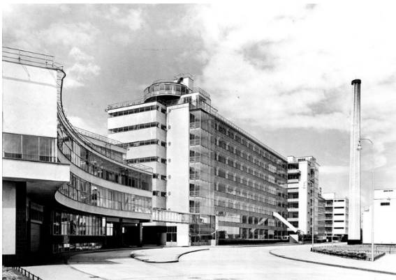
Imagen 7. Fábrica Van Nelle de Brinkman y Van der Vlugt. Rotterdam, 1925-1927. Consultada en http://www.tectonica.es/arquitectura/vi-drio/nuevo_mundo_de_relaciones.html .
