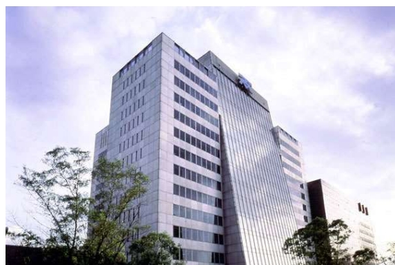
Imagen 73. Edificio oficinas centrales de Telmex. Consultada en https://mapio.net/pic/p-8639682/ .
