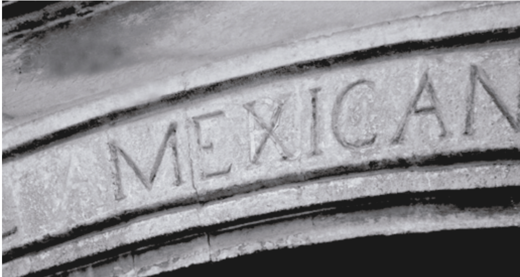
Figura 18. Texto tallado en el arco de la portada donde se aprecian las correcciones hechas en 1847. (Fierro Gossman, R. 2015a, noviembre 2).
