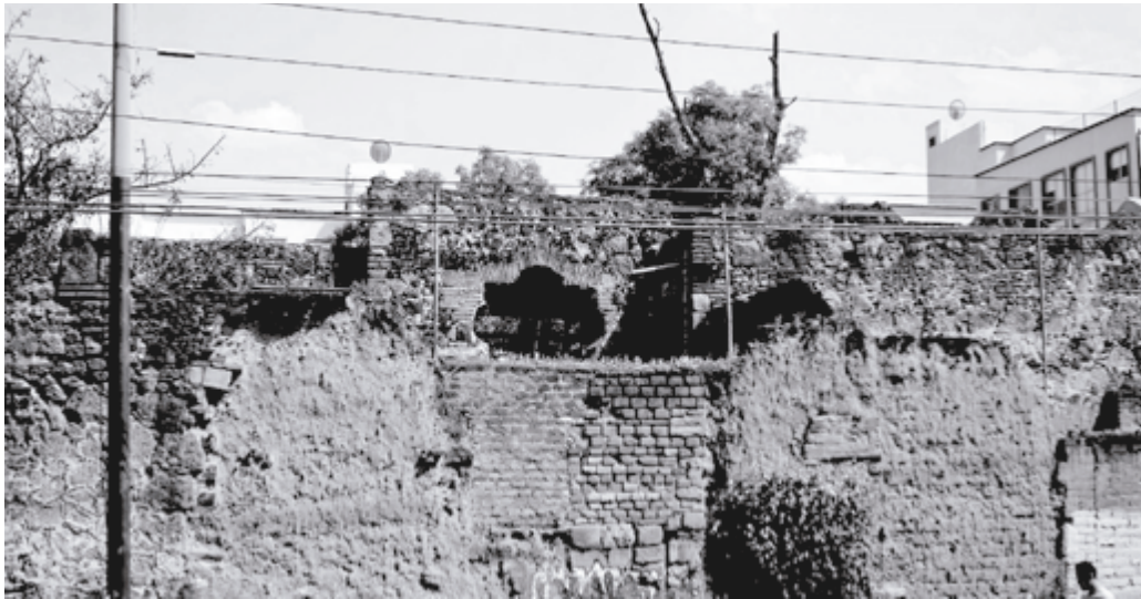
Figura 28. Vista desde Lago Chiem, donde destaca la ventana en cuadrifolio del pasillo principal de la casa. 2015. (Fierro Gossman R. 2015).
