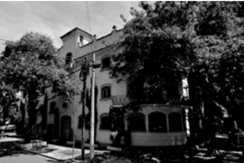
5.- Figura 68. Edificio Polanco.Imagen propia. 2019.
