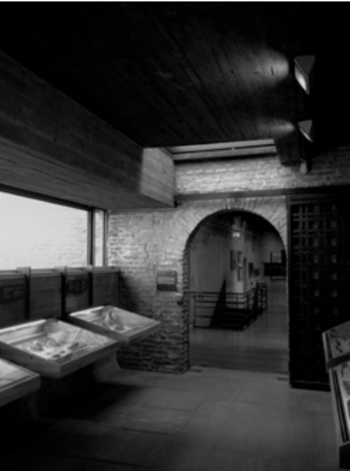
Figura 200. Los nuevos elementos arquitectónicos como puertas, cubiertas y mobiliario se superponen de forma sutil a los elementos históricos en este caso al muro antiguo. (imagen propia 2016).
