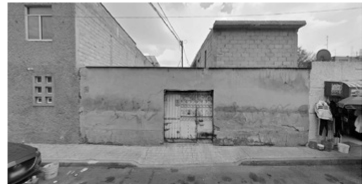
6 Figura 134. Lote con construcción en obra negra en aparente estado de abandono sobre el callejón Panal. (GOOGLE-EARTH, 2018).
