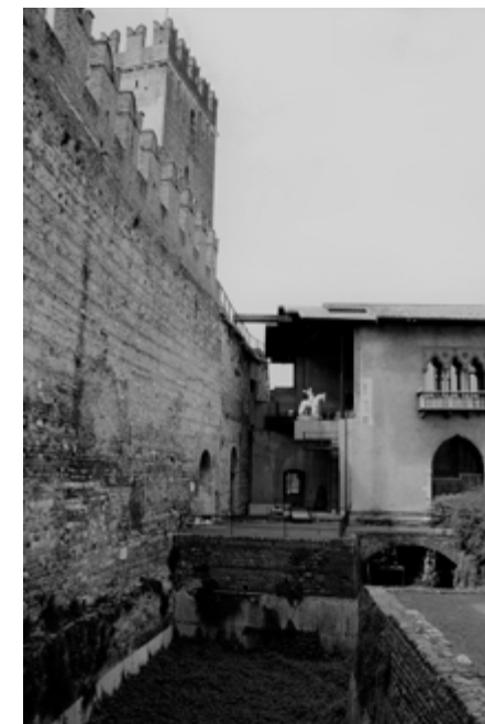
Figura 193. Antigua fosa descubierta excavada por Carlo Scarpa. (imagen propia 2016).
