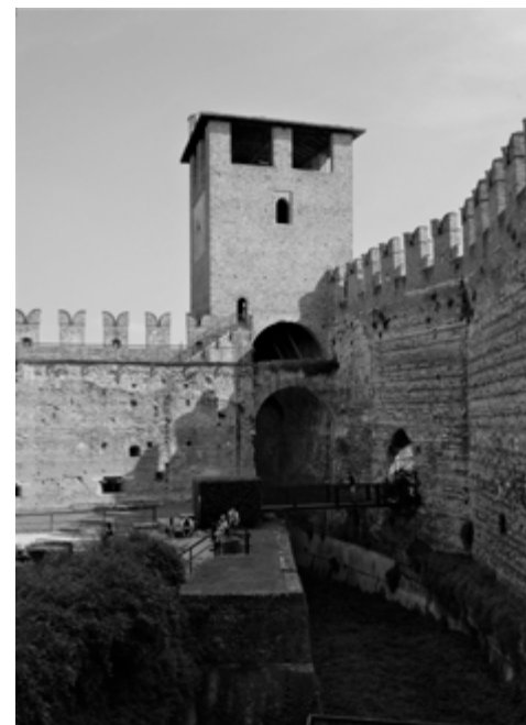
Figura 192. Se aprecia el puente construido sobre la antigua fosa excavada. (imagen propia 2016).
