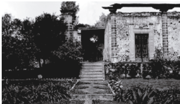
Figura 22. Vista de la casa de descanso desde el jardín, se aprecia el porticado remanente que llegaba hasta la capilla. (Fierro Gossman, R. 2015a, noviembre 2).
