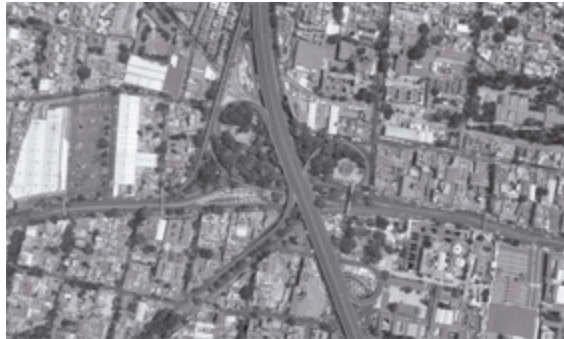
Nodo 10.- Figura 114. Distribuidor Vial Calzada México-Tacuba-Av. Marina Nacional. (GOOGLE-EARTH. 2018).
