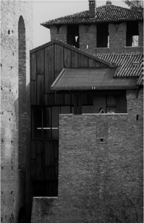
Figura 204. Corte hecho a uno de los muros de la Caserna para separarla de la Torre principal del castillo, el espacio fue aprovechado para crear una terraza con vista al río Adigio.(imagen propia 2016).
