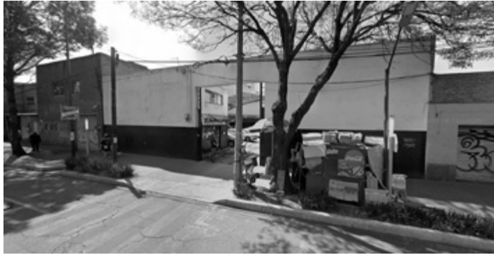
1 Figura 129. Estacionamiento público antes almacén sobre av. Lago Chiem. (GOOGLE-EARTH, 2018).
