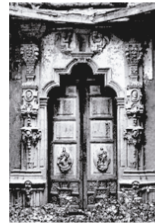
Figura 32. Portada de acceso central de la capilla después del colapso del techo de la terraza. 1957. (Fierro Gossman R. 2015).
