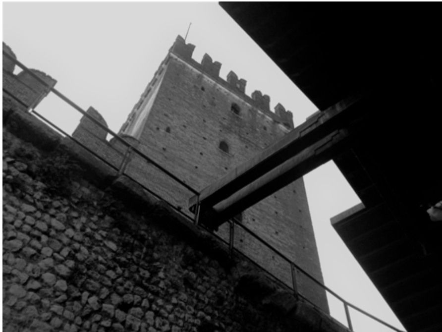
Figura 211. Vista de la torre principal del Castelvecchio, se aprecia la sutil unión entre la cubierta de la Caserna y el edificio histórico, fotografía tomada desde el espacio del Congrande. (imagen propia 2016).
