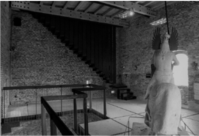
Figura 202. Escaleras de acero ancladas en el muro de una de las torres del castillo histórico (imagen propia 2016).
