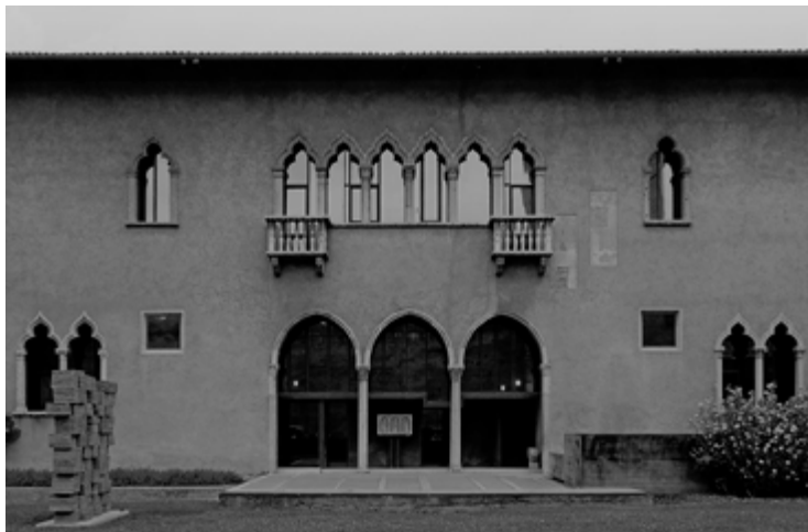
Figura 187. Uso de diferentes materiales en uno de los muros que formaron parte de la obra nueva en el museo de Castelvechio. (Theodorakakis Theso, 2017.)
