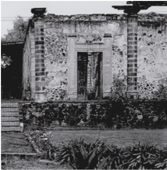
Figura 24. Vista parcial del estado actual de la casa de descanso desde el jardín.(Fierro Gossman, R. 2015a, noviembre 2).
