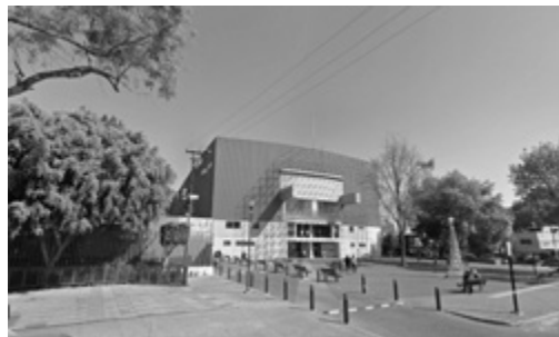
6.- Figura 92. Deportivo Pavón. (GOOGLE-EARTH. 2018).
