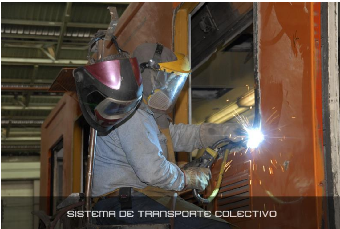
Foto 10. Reparaciones a vagón del Metro, foto difundida por el STC
