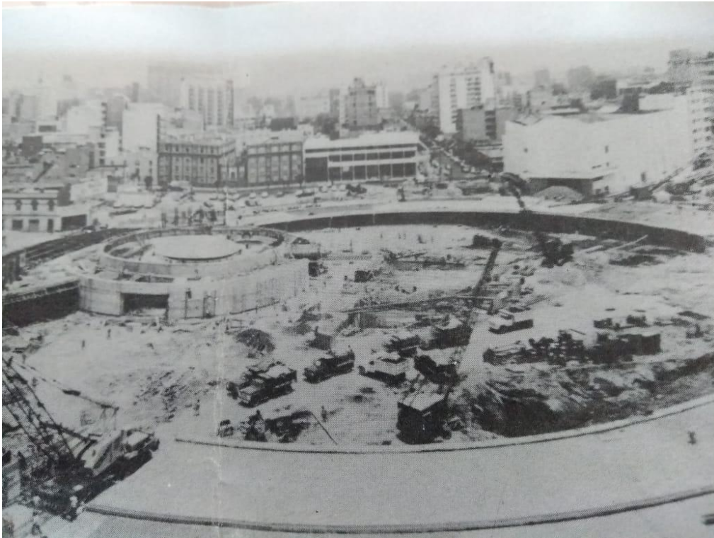
Foto 1: Obras de construcción de la estación Insurgentes en 1967. Foto difundida por el STC
