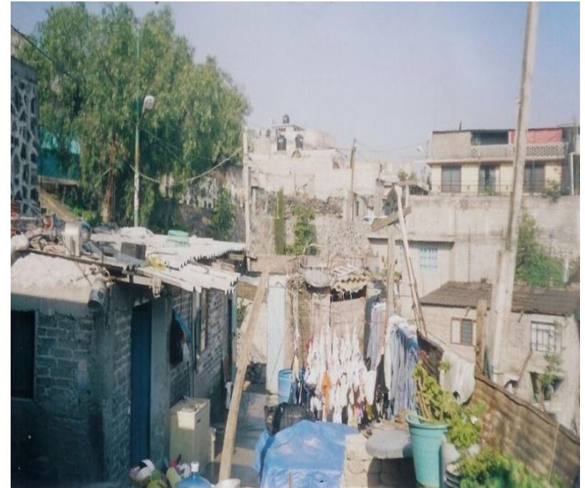
SIERRA DE SANTA CATARINA IZTAPALAPA - VIVIENDA DE AUTOCONSTRUCCIÓN (IMAGEN DEL AUTOR)
