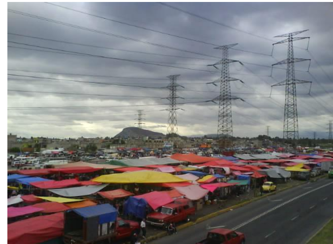
TIANGUIS EJE 6 AV. DE LAS TORRES (IMÁGENES DEL AUTOR)
