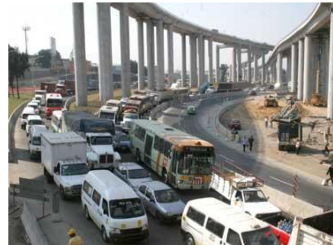
PUENTE DE LA CONCORDIA AV. ERMITA IZTAPALAPA
