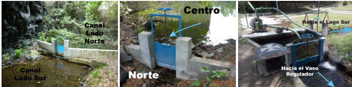
Fig. 14 Compuertas de regulación en el canal, en los lagos someros Norte-Centro y en el lago Sur-VR respectivamente.
