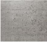
Aplanado de concreto aparente liso con llana metálica
