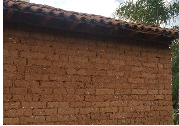
Fig. 53 Vivienda vernácula posiblemente nueva
