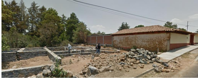
Fig. 130 Cimientos de piedra para vivienda junto a vivienda vernácula
