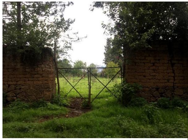
Fig. 51 Acceso a lote con muro de adobe
