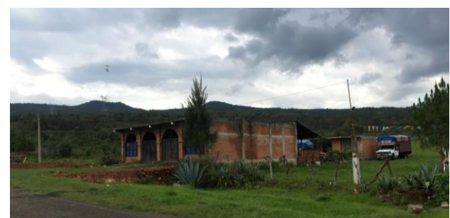
Fig. 84 Nueva vivienda con materiales industriales.
