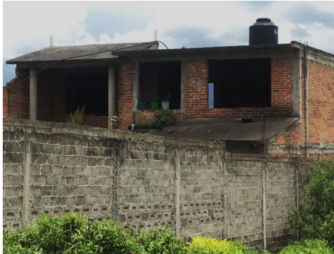
Fig 36..Segundo piso de vivienda nueva sin terminar.
