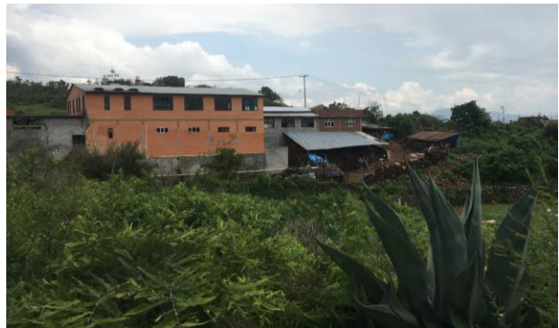
Fig. 68 Misma construcción de Block terminada, 2019
