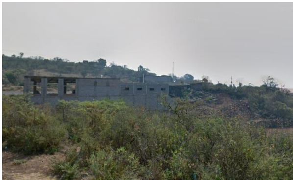
Fig. 67 Construcción de Block en proceso, 2012
