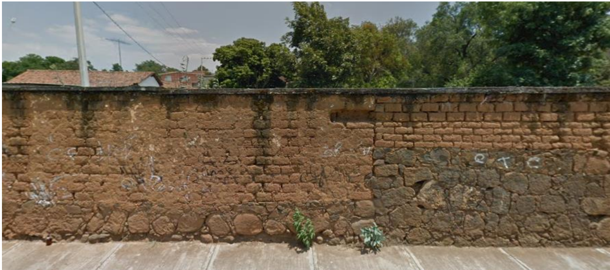
Fig. 131 Detalle de muro de adobe con cimiento de piedra en Lázaro Cárdenas.
