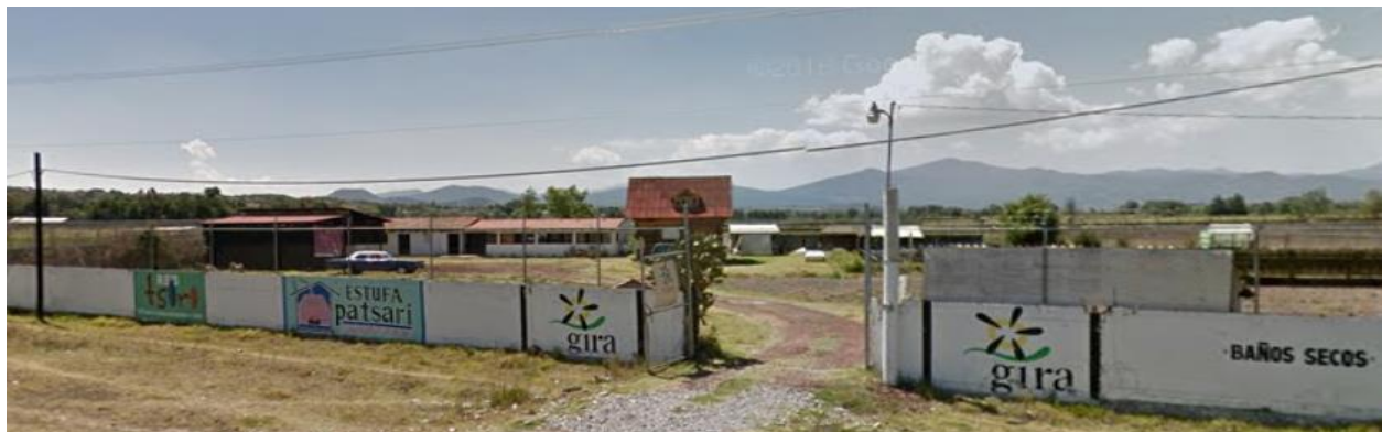
Fig. 128 Instalaciones de GIRA A.C. en Tzetzenguaró
