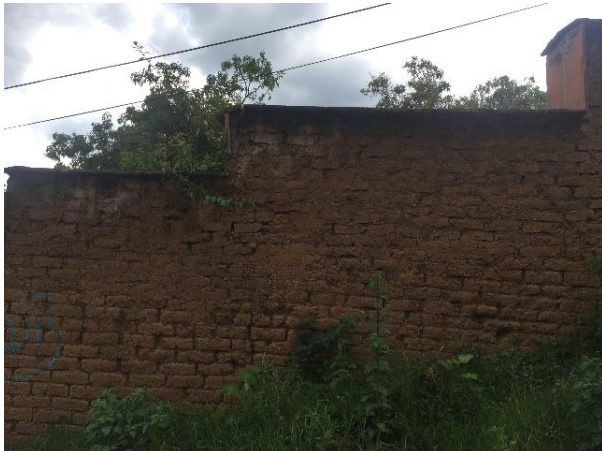
Fig. 50 Muro exterior de vivienda vernácula
