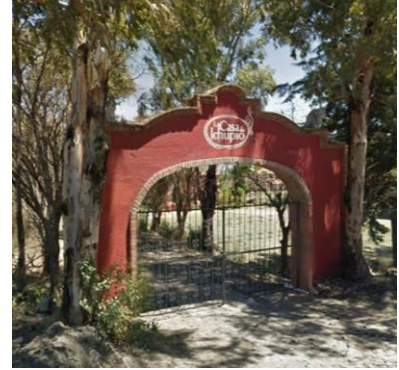
Fig. 105 Acceso a centro de alojamiento "la casa de Ichupio"
