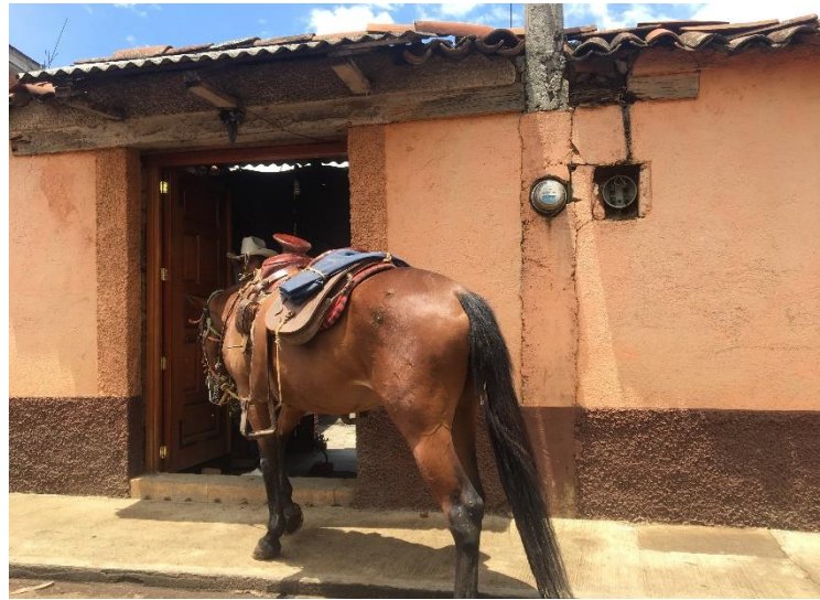
Fig 44 Vivienda Vernácula con agregados en concreto.
