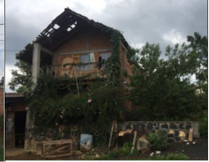
Fig. 77 vivienda de tabique con base de piedra, estilo aparentemente más rústico
