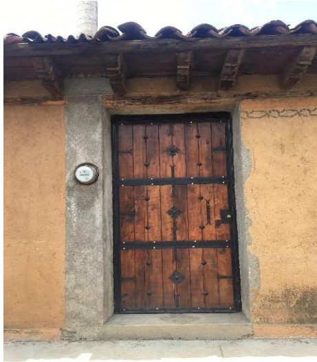
Fig 43 Vivienda Vernácula con agregados en concreto.
