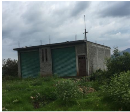
Fig. 93 Construcción con materiales industriales en las afueras de Quiroga.
