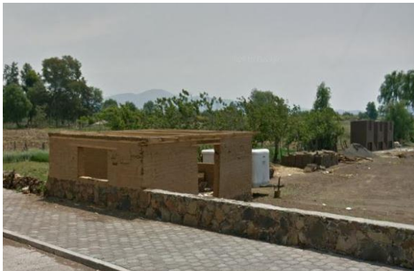
Fig. 60 Inicio de construcción de adobe 2012
