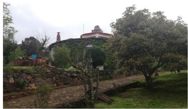
Fig. 102 Vivienda con mezcla de de estilos y materiales, incorporando características de la arquitectura vernácula.
