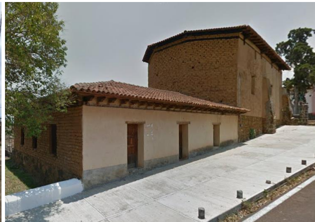
Fig. 151 Fachadas en el centro de la comunidad Lázaro Cárdenas Fotografía: Sara Navia 2020
