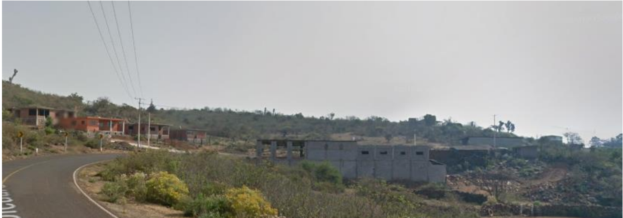
Fig. 66 paisaje entrando al pueblo Oponguio 2012, Construcción de block en medio
