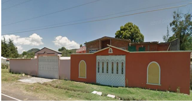
Fig. 124 Nuevas formas de hacer arquitectura
