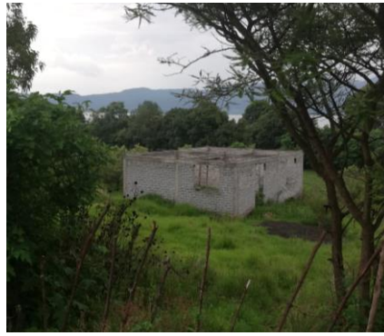
Fig. 104 Nueva construcción incompleta de materiales industriales en condición de abandono.
