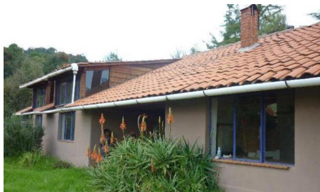
Fig. 149 Captación pluvial en vivienda en Erongaricuaró Fotografía: SEDUVI
