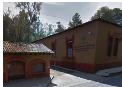
Fig. 116 Preparatoria CONALEP en construcción vernácula
