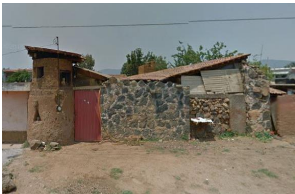
Fig 40 Vivienda adobe y piedra 2012 (Street view)
