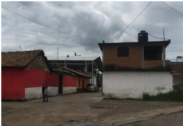
Fig.28 Vivienda vernácula frente a nueva forma de vivienda
