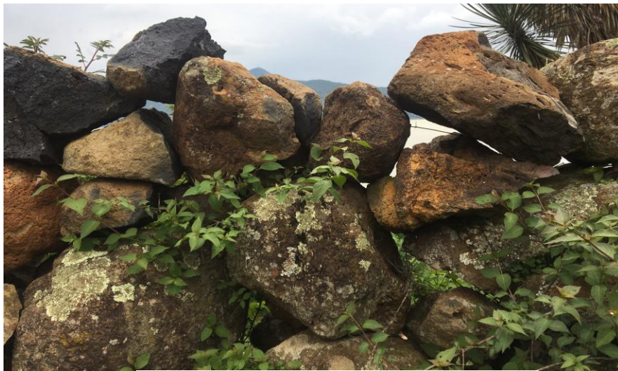
Fig. 64 Muro de piedras apiladas en Onponguio
