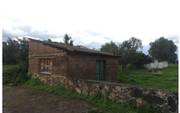
Fig. 61 Misma construcción de adobe 2019
