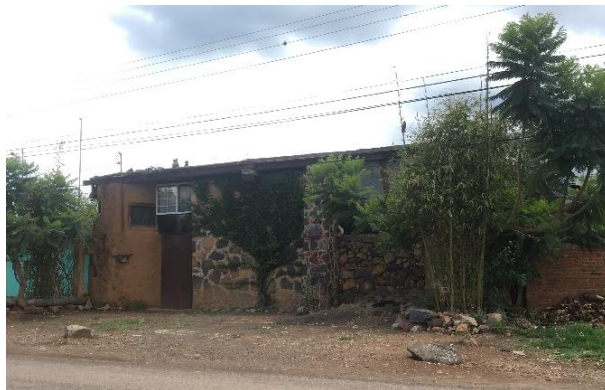
Fig 41 Vivienda adobe y piedra 2019, Foto actual
