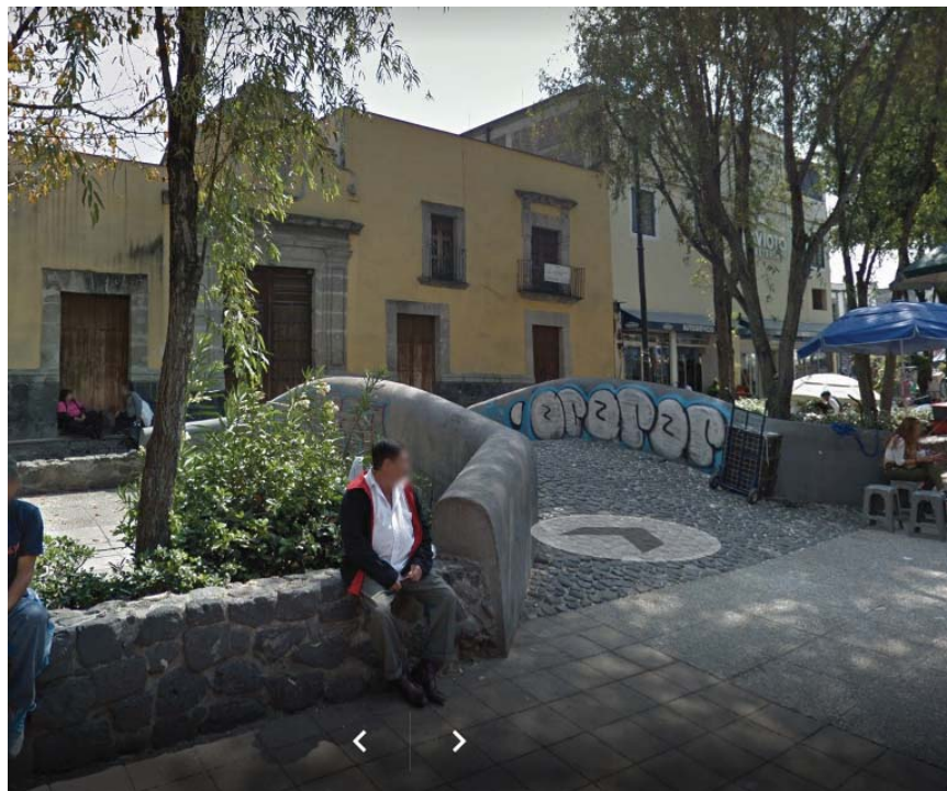
Figura 47. Vista del puente actual en la calle Alhóndiga. (Toma de GoogleMaps).
