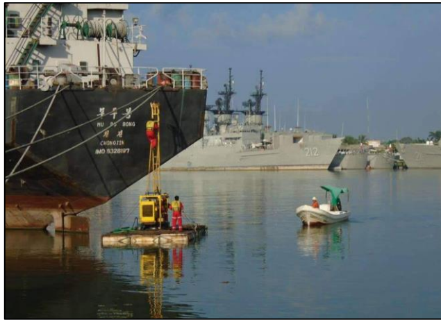
Figura 28. Realización de un estudio geotécnico para la construcción de un muelle.
