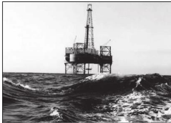
Imagen 5 Primer Plataforma Auto Elevable del mundo en el Golfo de México, bautizada "Scorpio" (tomada de Development of the Offshore Industry, by Víctor A. Schmidt, 2008)
