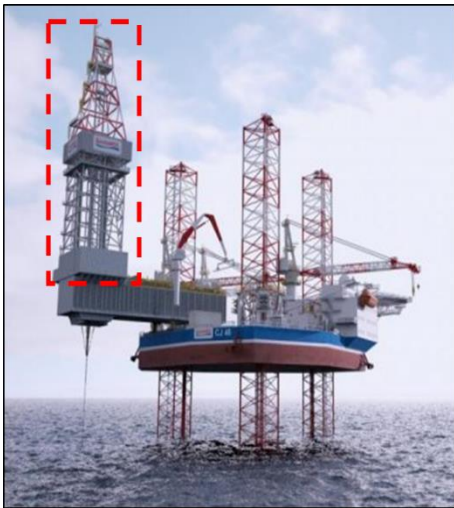
Imagen 11 Unidad de Perforación de una Plataforma Auto Elevable (Tomada de Petróleos Mexicanos, 2019)
