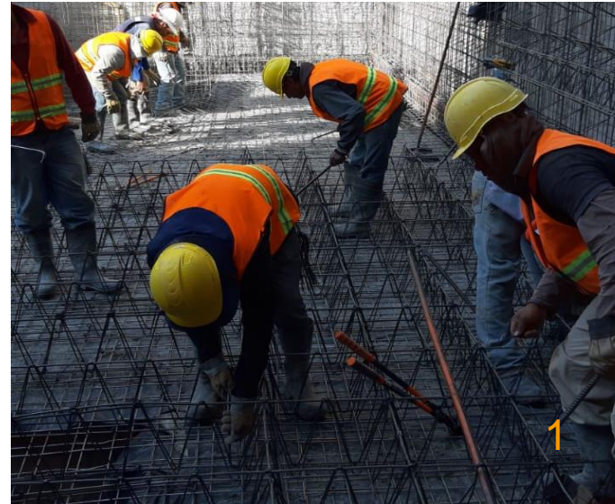
Imagen 26. Proceso de elaboración de losa
