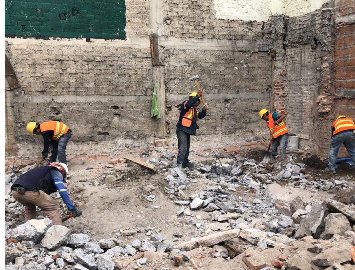
Imagen 33. Demolición de losa.
