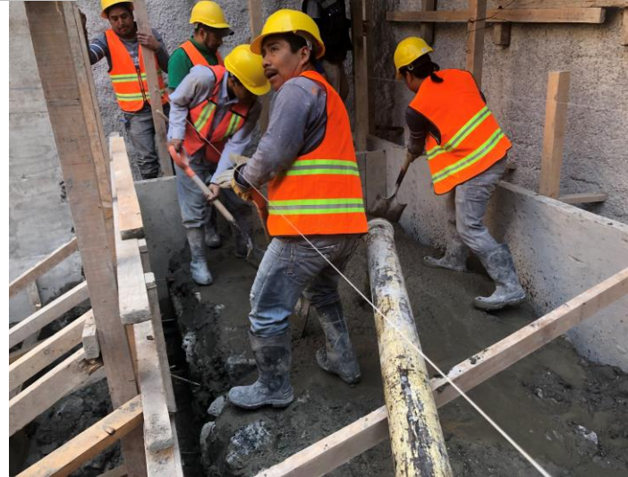
Imagen 10. Vaciado de concreto.
