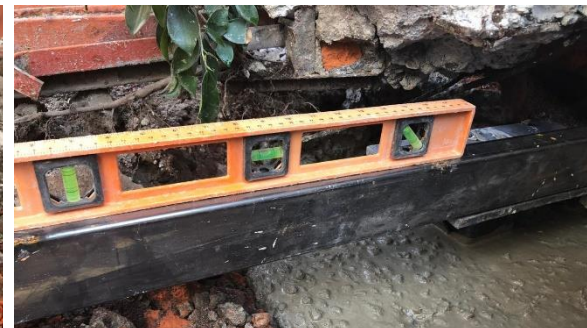
Imagen 08 Verificación de nivel con nivel de mano.
