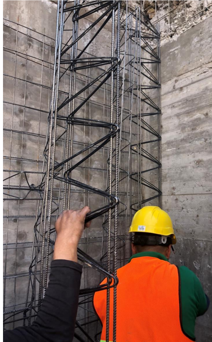
Imagen 21. Armado de columna con una tira de triángulos invertidos.
