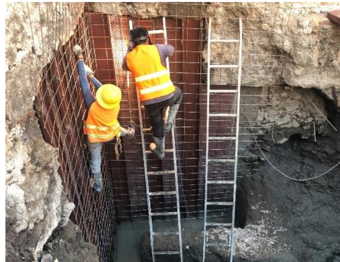
Imagen 29. Trabajando en los ejes 12-14 del a y 14.
