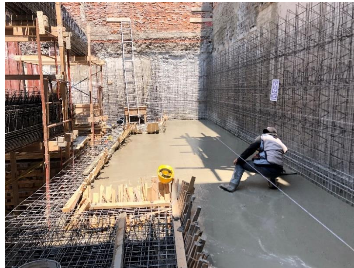
Imagen 46. Inicio de pulido de losa.
