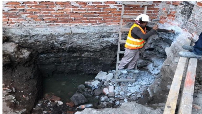
Imagen 17. Sacando el agua para continuar la excavación.
