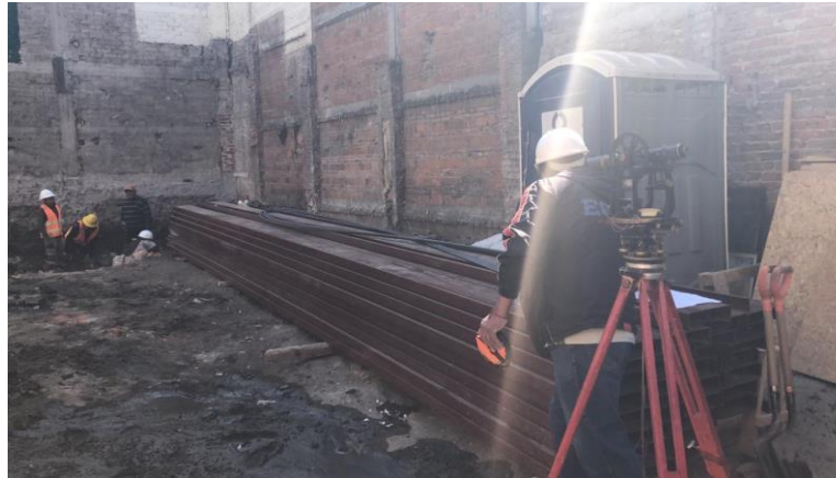
Imagen 22. Trazando el eje 6
