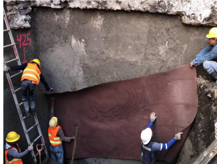
Imagen 10. Colocación de membrana atlas.
