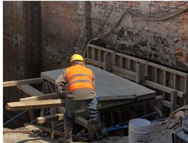
Imagen 61. Preparando tarimas para cimbrar .
