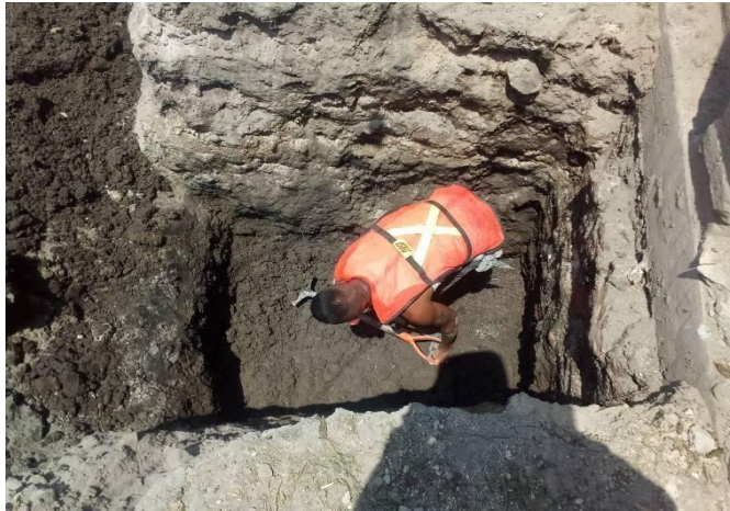
Imagen 07. Excavación de pozo manual
