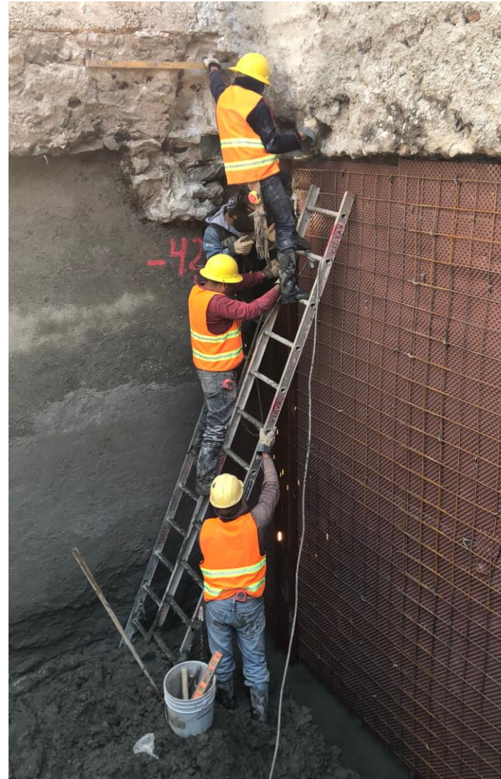
Imagen 12. Colocación de malla estructural de 6x6.
