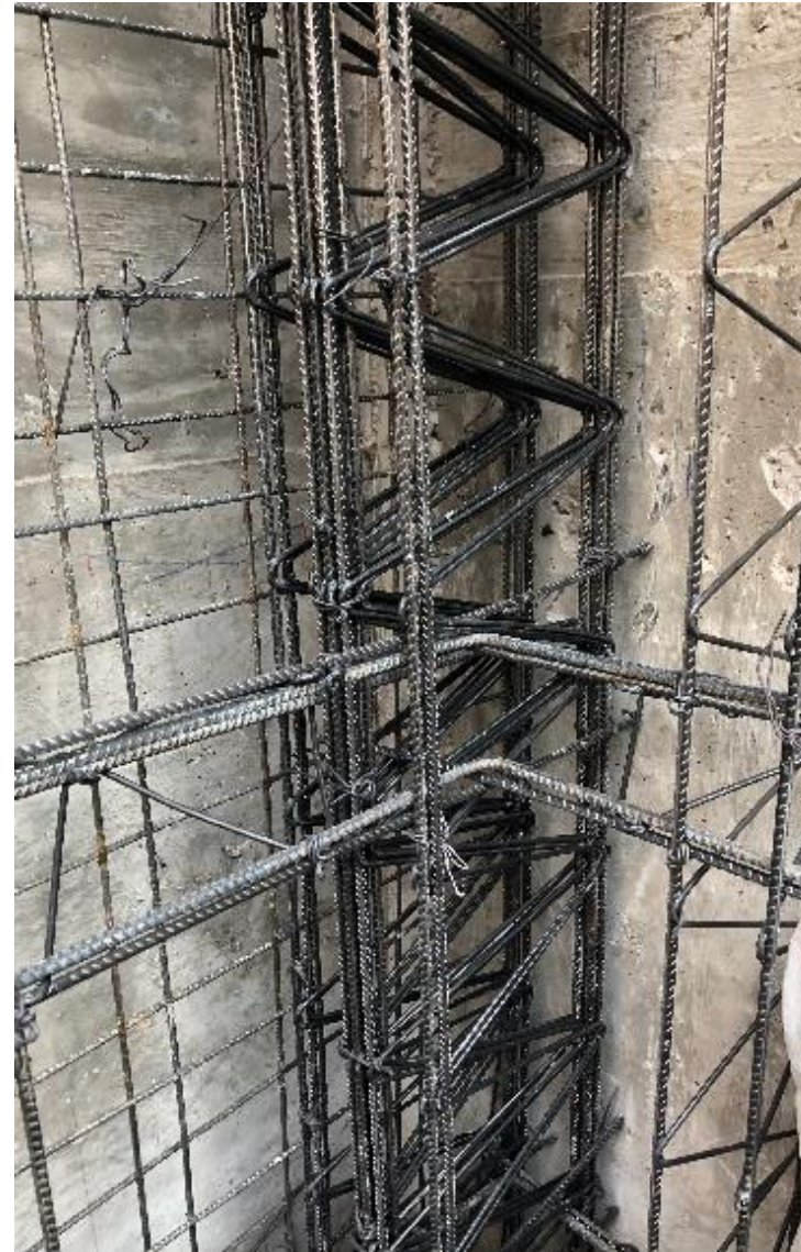
Imagen 58. Detalle en obra, aprobado por DRO.
