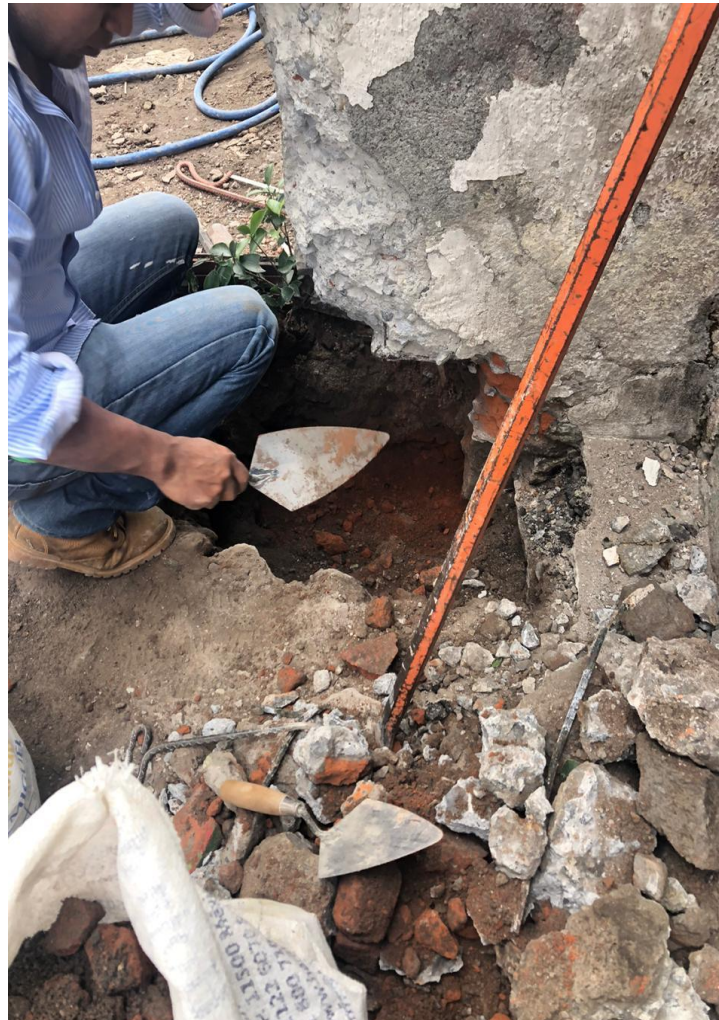
Imagen 03. Excavación manual y perfilado .
