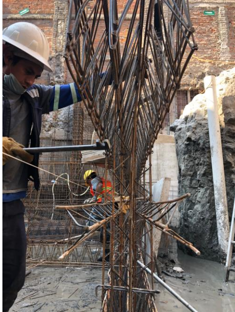
Imagen 70. Vista frontal de la CCT eje H.
