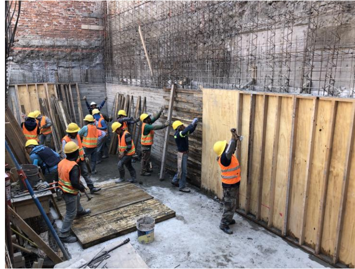
Imagen 66. Descimbrando el muro estructural.
