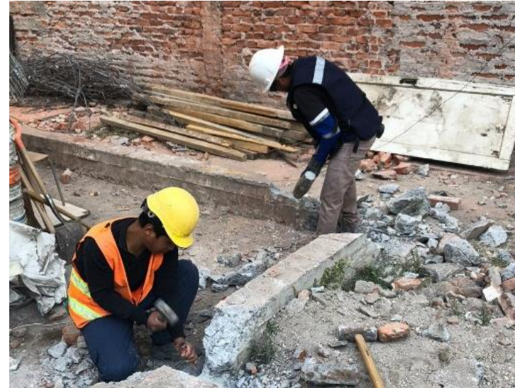
Imagen 31. Continuación de la demolición de trabe.
