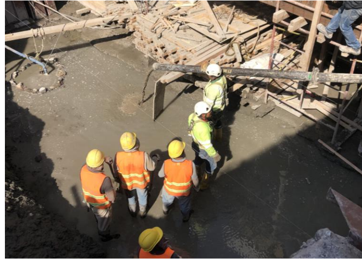
Imagen 64. Se cambia la tubería, para iniciar el proceso de colado de la plantilla como se muestra en planos.
