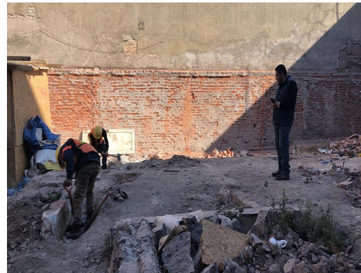
Imagen 28. Demolición de trabe.
