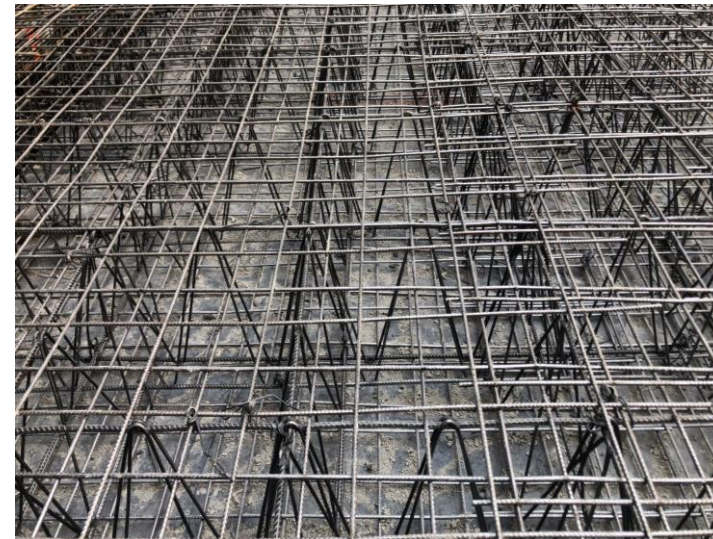
Imagen 38. Vista de izquierda a derecha de losa armada.
