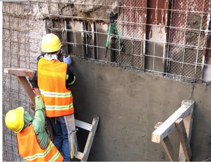
Imagen 39. Cimbrado de ajuste de muro.
