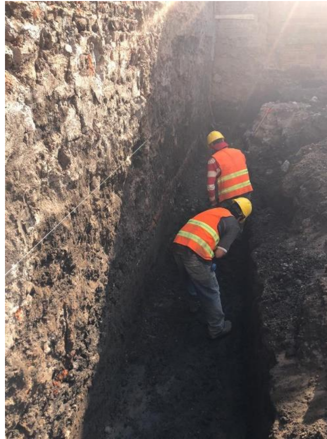
Imagen 20. Excavando a - 2.60, en el área marcada en verde.
