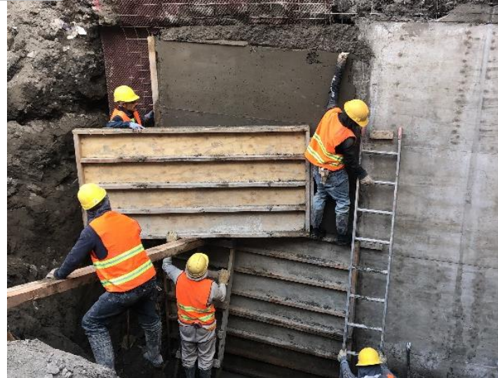
Imagen 46. Descimbrado muro de tabla estacado.
