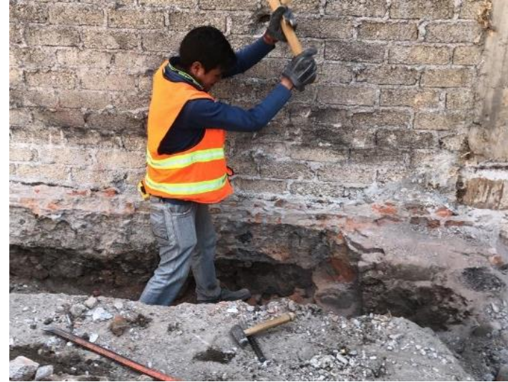
Imagen 06. Demolición de dala.
