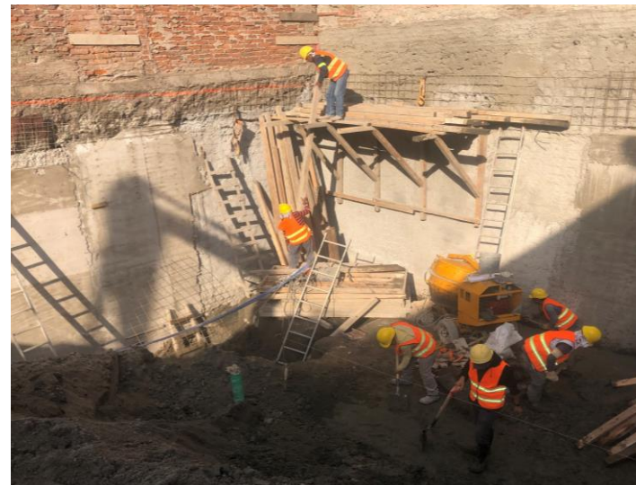
Imagen 02. Caballete aéreo en muro colindante .
