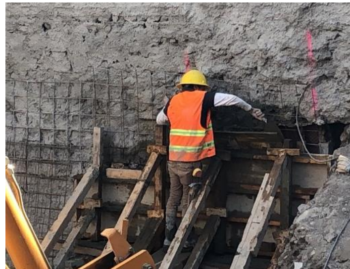
Imagen 36. Colando los muros de protección a colindancia.
