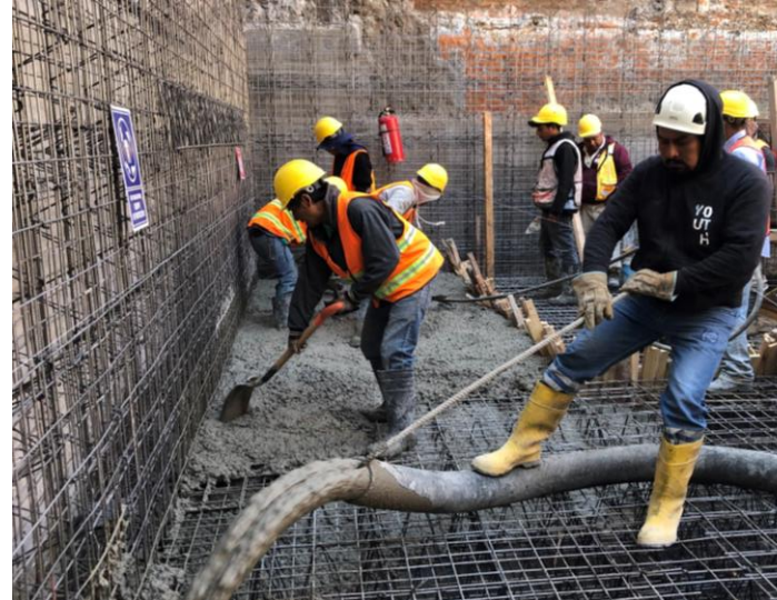
Imagen 43. Inicio del colado de losa.
