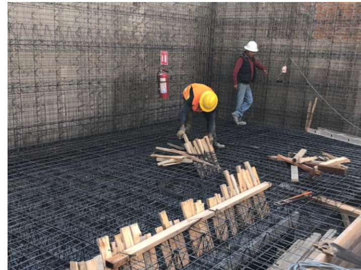
Imagen 40. Foto donde muestra que se parten polines para sacar las astillas.
