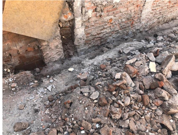
Imagen 27. Demolición de dala de desplante.
