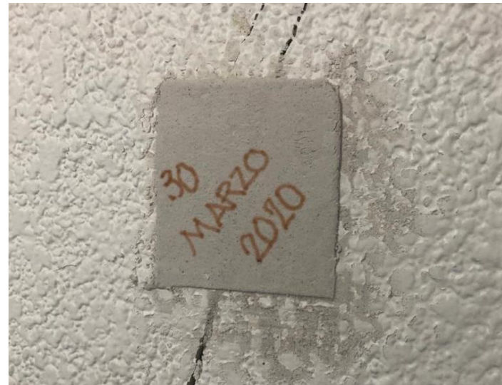
Imagen 57. Colocación de testigos.
