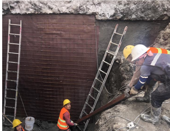
Imagen 16. Bajando el monten estructural .
