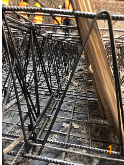
Imagen 48. Armado con cimbra o frontera para colar.
