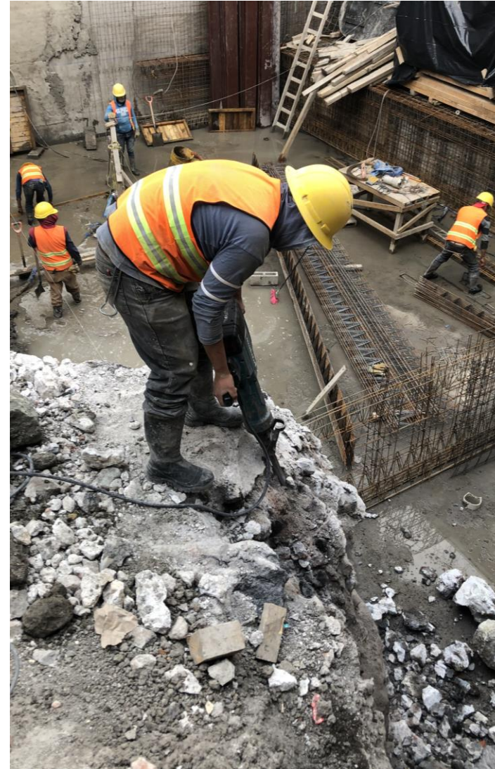
Imagen 73. Demolición de cimentación para colocación de CCT.
