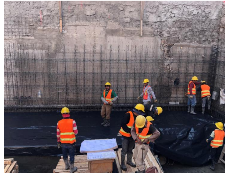
Imagen 33. Colocación de polietileno.
