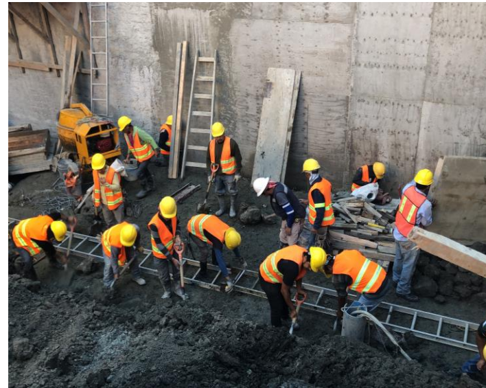
Imagen 01. Afine y compactación de tierra .
