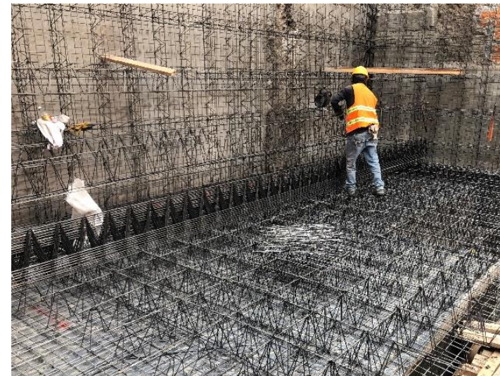
Imagen 36. Armado de losa en sentido horizontal.
