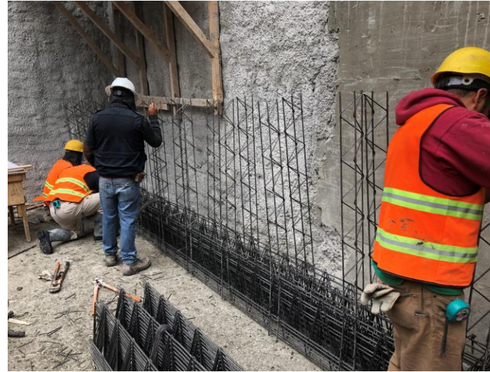
Imagen 15. CCT en su lugar y elaboración de muro
