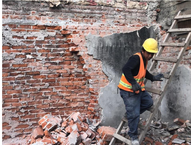
Imagen 24. Demolición, con maceta y cincel
