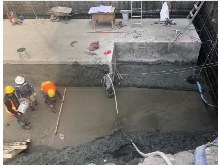
Imagen 28. Nivelación de plantilla de para el desplante del armado de losa del cárcamo.
