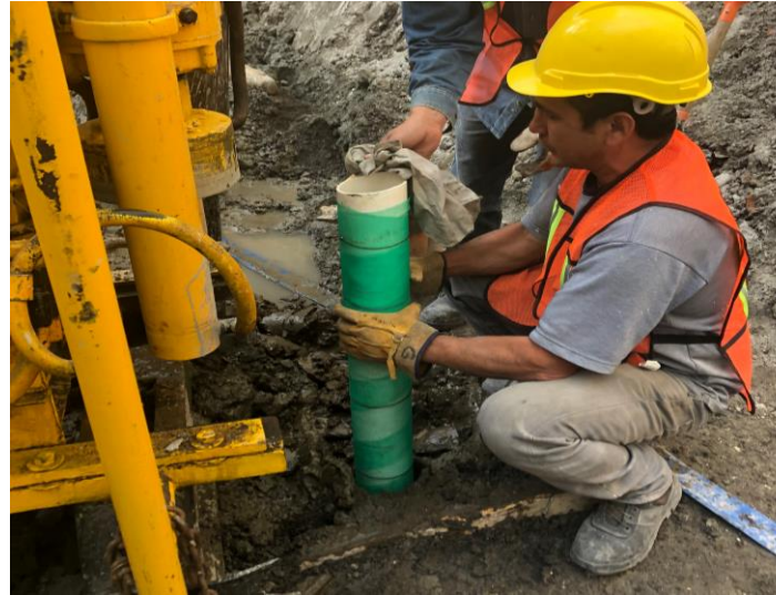
Imagen 26. Tubo de PVC, para colocación de bomba misil.
