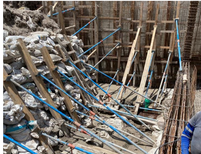
Imagen 65. Aseguramiento de obra con costales y apuntalamiento de acero .
