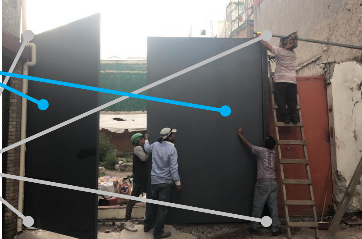
Imagen 15. Colocación de hojas de acero, donde se dará el acceso vehicular .
