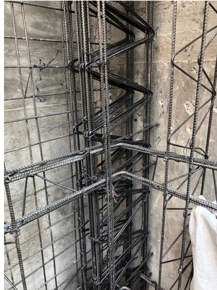
Imagen 25. Columna del eje 14 y A con refuerzo en horizontal .
