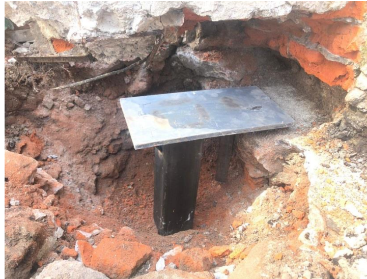
Imagen 04. Posicionamiento de placa de acero.
