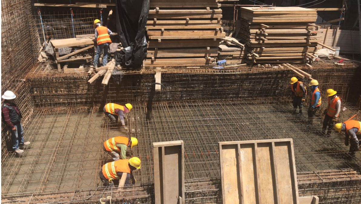
Imagen 77. Armado de losa entre los ejes 1-9'.
