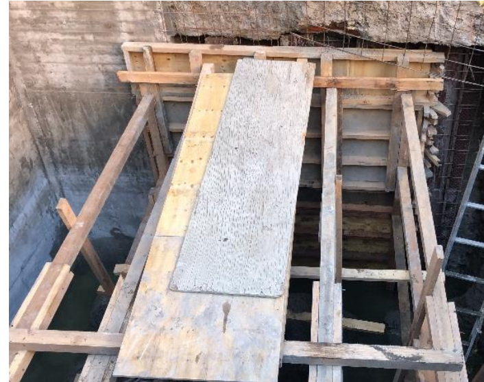
Imagen 44. Cimbrado de tabla estacado (LADO DERECHO).
