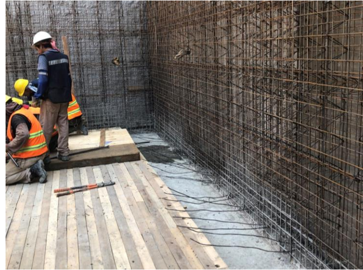
Imagen 50. Terminando la cimbra corrida.
