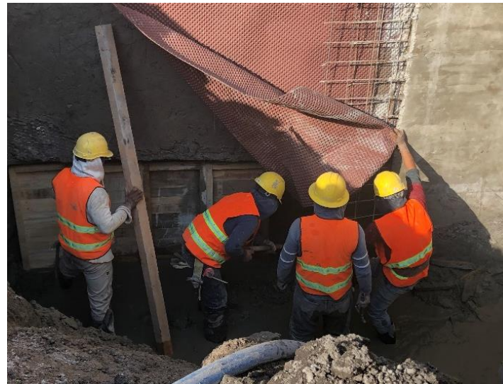
Imagen 47. Colocación de tarimas por desprendimiento de tierra.
