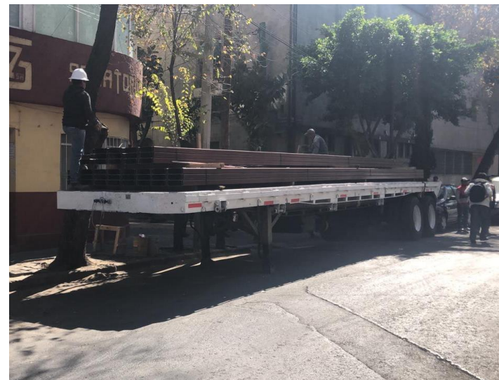
Imagen 02. Descargando plataforma de montenes .
