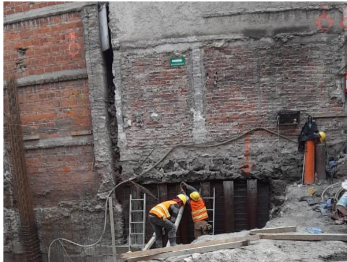
Imagen 59. Colocación de malla electro soldada.
