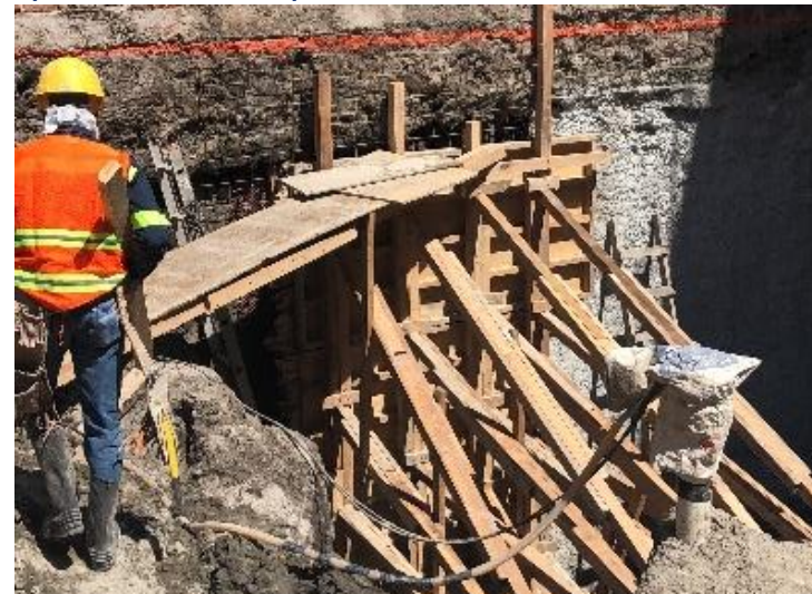
Imagen 45. Andamio para colar muro de P.C. (LADO IZQ).
