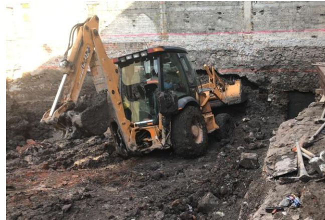
Imagen 21. Compactando la tierra, donde se origino el deslave.
