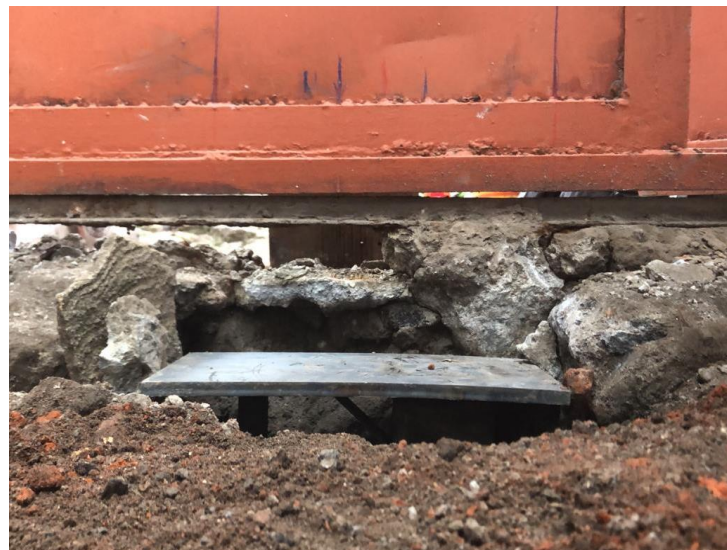
Imagen 10. posicionamiento de base de acero.
