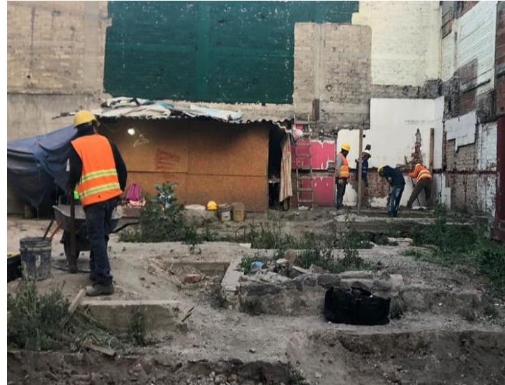
Imagen 22. Demolición de muro en ejes 10 – 14.
