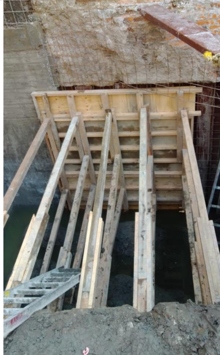
Imagen 51. Cimbrado de muro a P.C.
