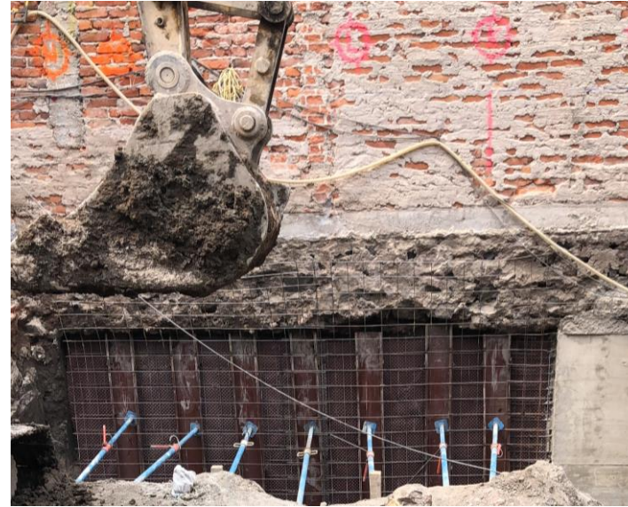
Imagen 60. Acabando con el proceso de colocación de montenes .
