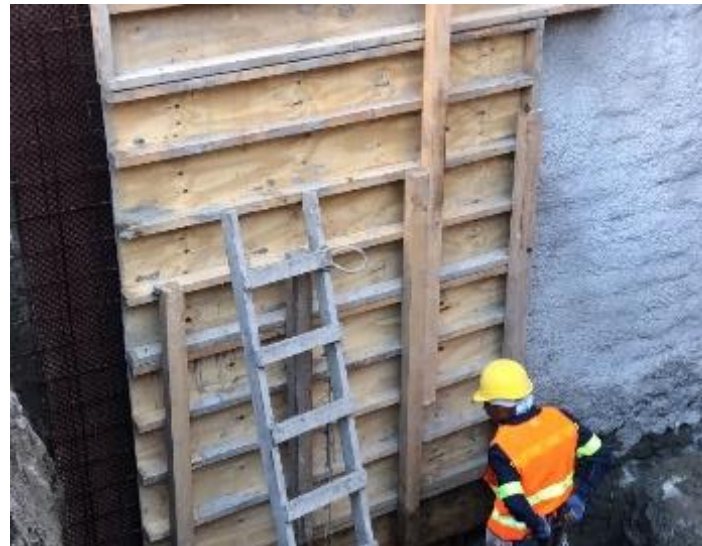
Imagen 38. Cimbrado de muro.
