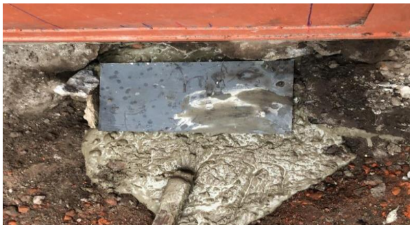
Imagen 07. Colado de la primera base de acero en proceso de colado.
