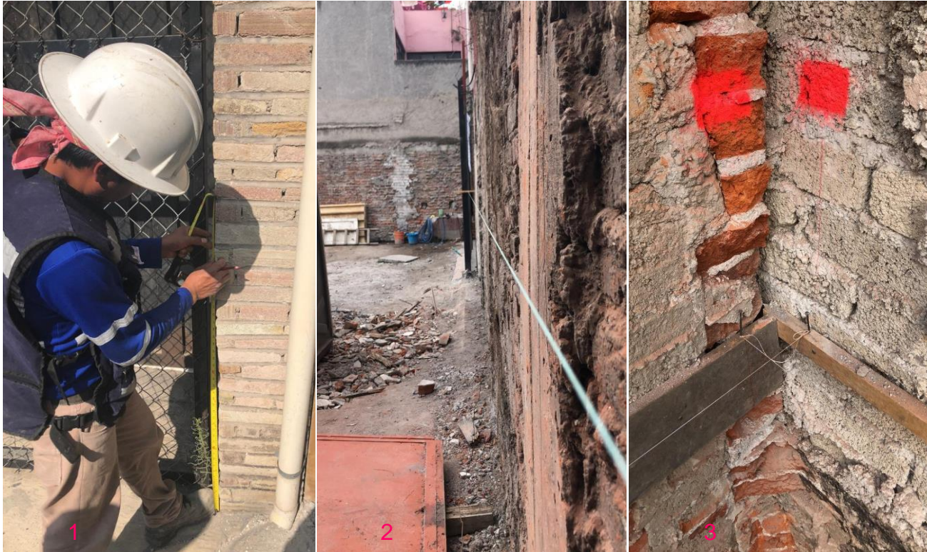
Imagen 04 Visualización del reventón a 1 metro del N.P.T.
