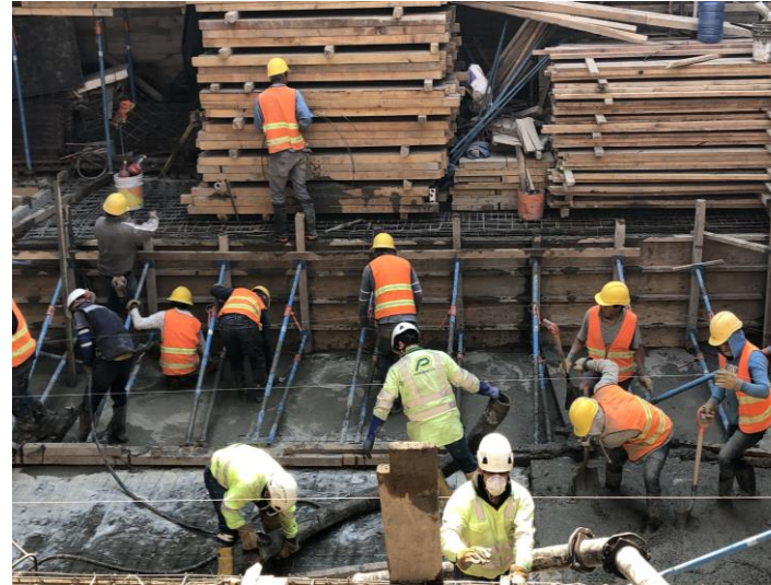
Imagen 79. Colando losa de cisterna.
