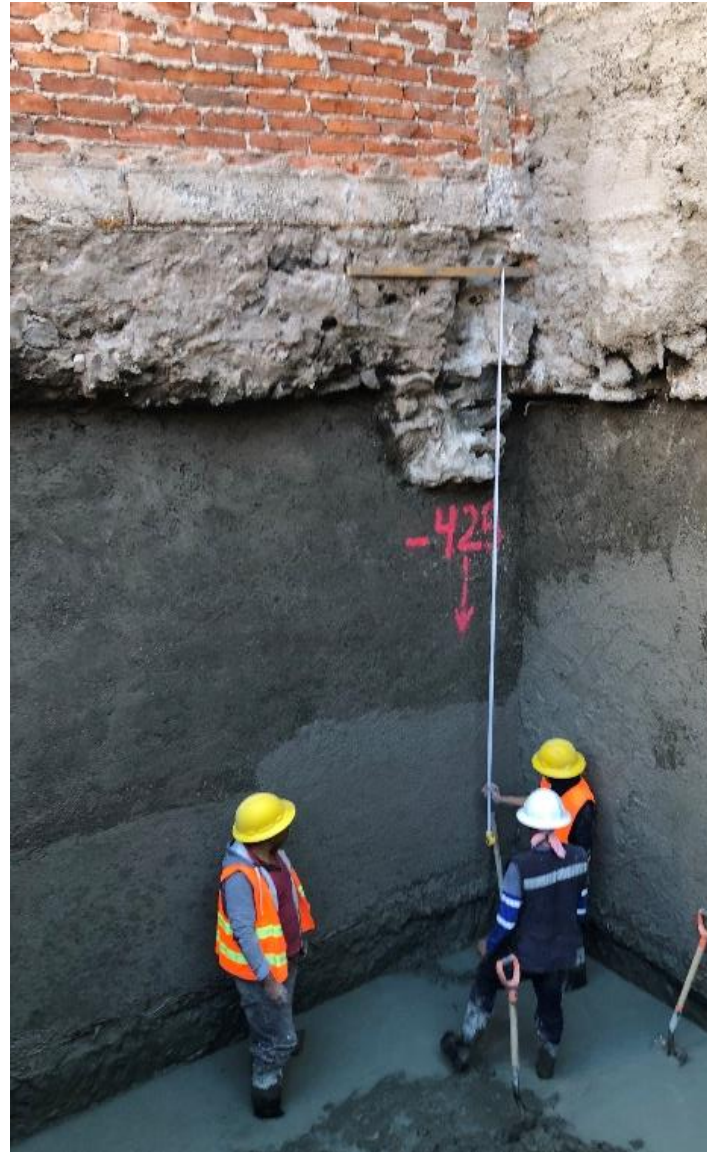
Imagen 05. Corroborando el nivel de excavación.
