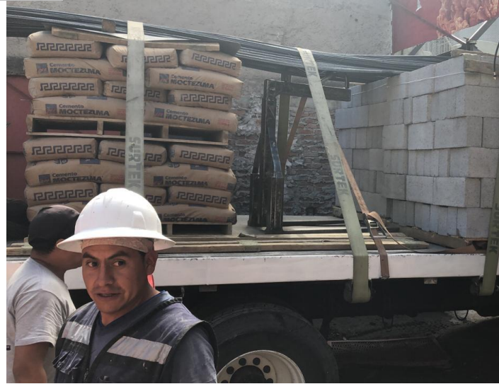
Imagen 03. Descarga de bultos de cemento
