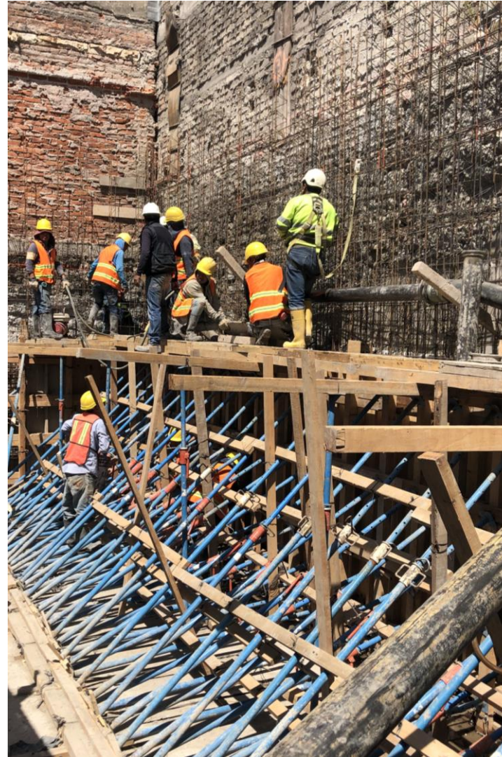
Imagen 63. Colando el muro estructural
