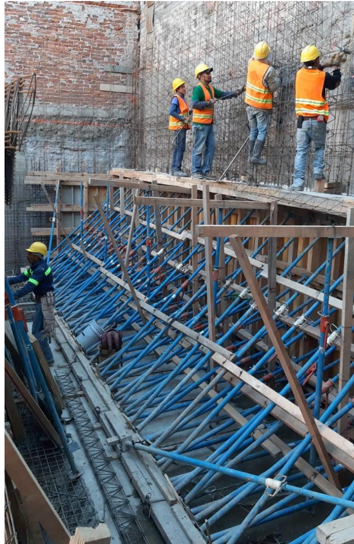
Imagen 62. Cimbrado el tramo en U invertida para colar.
