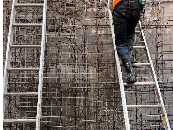
Imagen 52. Colocación de castillos faltantes.
