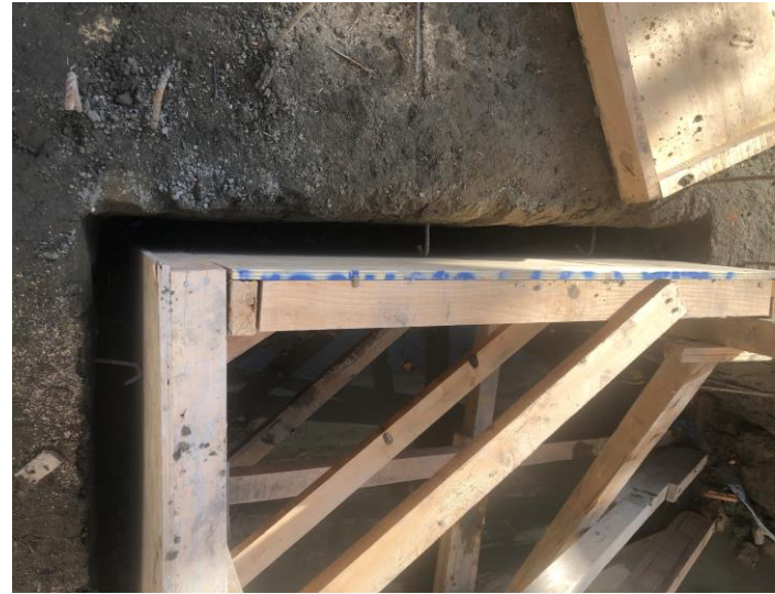
Imagen 06. Cimbrado para plantilla del eje A.
