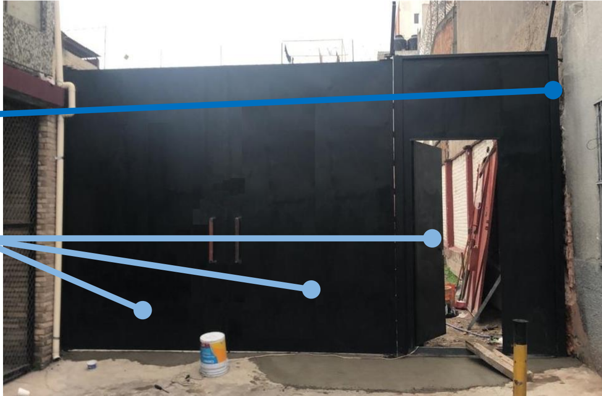
Imagen 16. Finalización de la colocación del zaguán.
