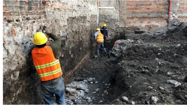
Imagen 19. Trabajos entre ejes 3 – 12.
