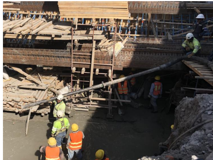
Imagen 65. Vaciado de concreto para plantilla.
