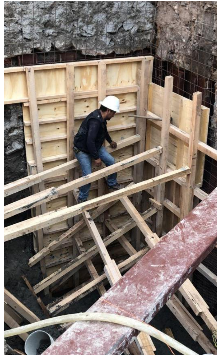
Imagen 30. Proceso de colado entre los ejes 14-A.
