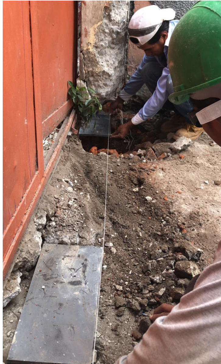
Imagen 11. Alineación de las placas.
