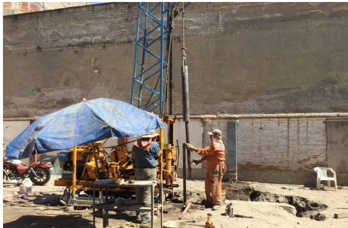
Imagen 03. Colocación de extensión para perforar .
