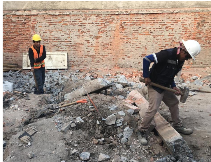
Imagen 30. Demolición de trabe .
