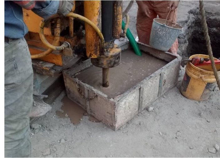
Imagen 02. Perforación de pozo con lodo bentónico.
