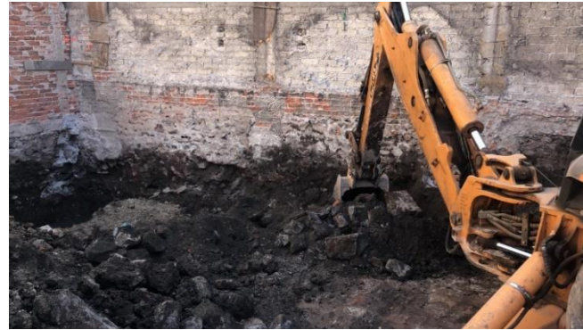
Imagen 18. Excavando en el 1c.
