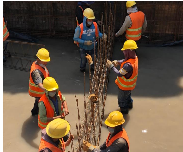
Imagen 69. Proceso de armado CCT eje 9'.
