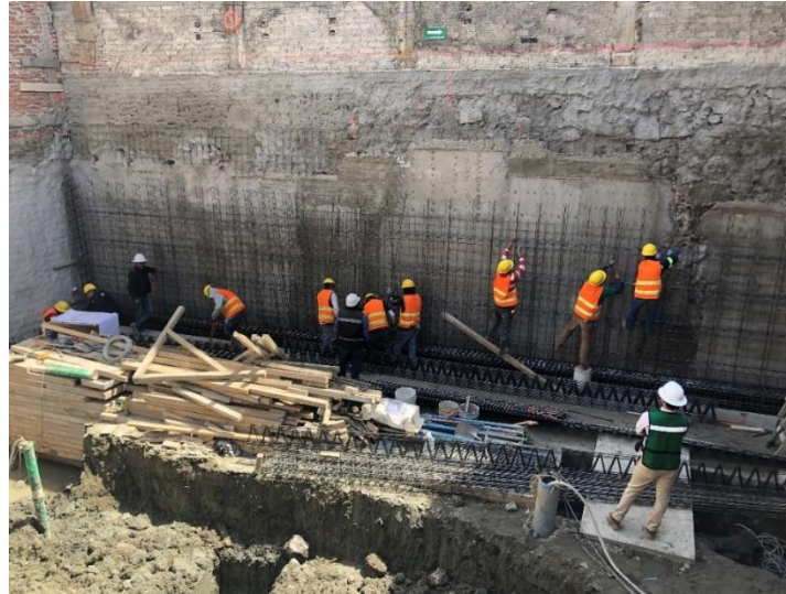
Imagen 20. En proceso de armado de muro.
