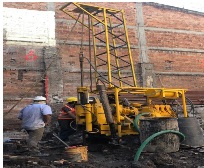
Imagen 27. Máquina en el proceso de perforación.
