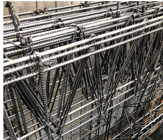
Imagen 27. Vista de la CCT del eje 1.
