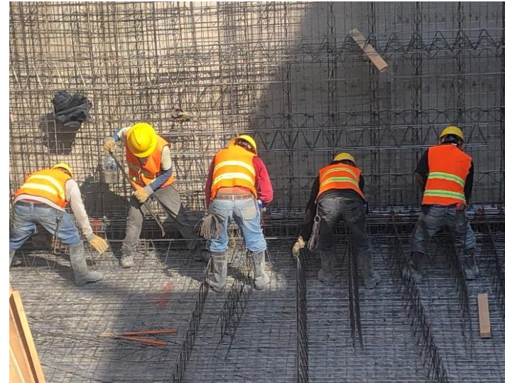
Imagen 35. Colocación del armado en sentido vertical, armado de losa semi sótano.
