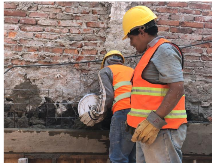
Imagen 63. Colando el muro en amarillo.
