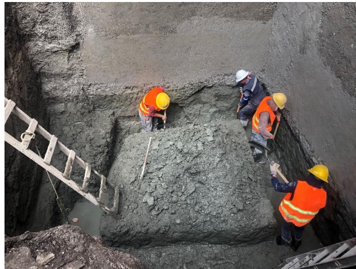
Imagen 09. Excavando zanja para tabla estacado.
