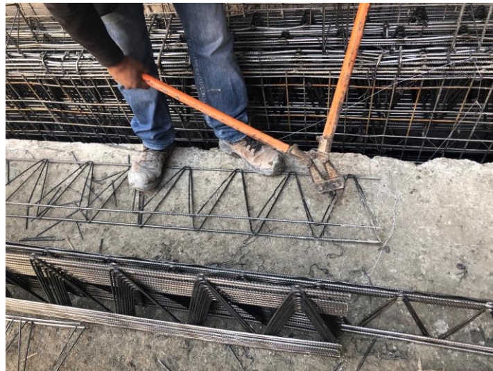
Imagen 19. Se cortan dos triángulos para el empalme.
