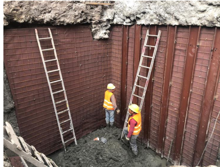
Imagen 19. Terminando el eje A con membrana en sentido horizontal.
