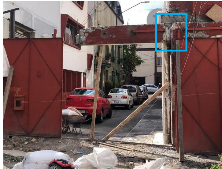
Imagen 12. Varillas expuestas, para iniciar el chaqueteo .
