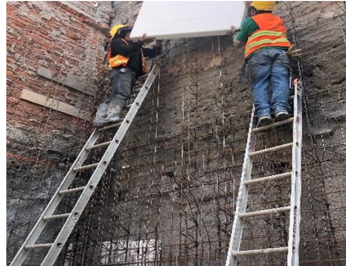
Imagen 54. Colocación del unisel.
