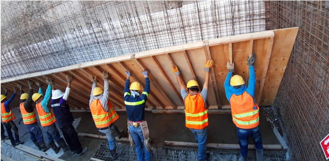
Imagen 61. Colocación del desmoldante.
