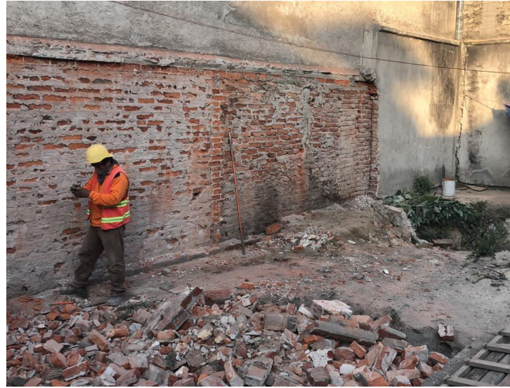
Imagen 21. Rellenando los hoyos.
