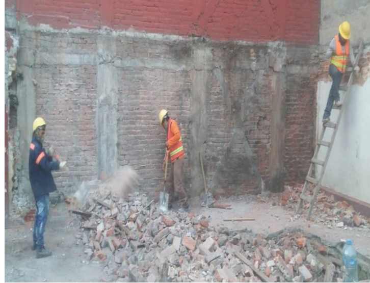
Imagen 17. Demolición de muro colindante.
