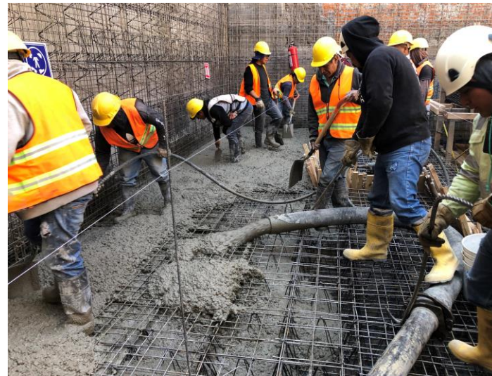
Imagen 44. 2da. Olla en proceso de colado.
