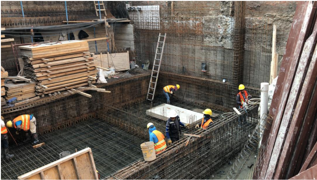
Imagen 75. Proceso de armado de losa de cisterna.
