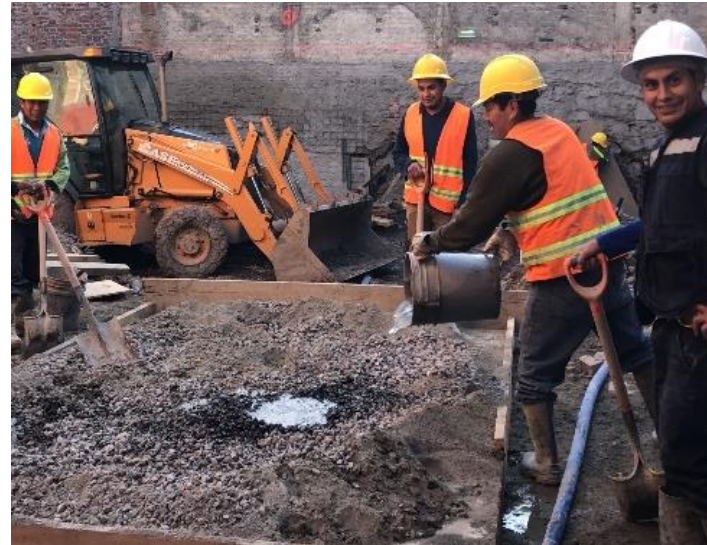
Imagen 35. Preparando el concreto de f'c=100 .
