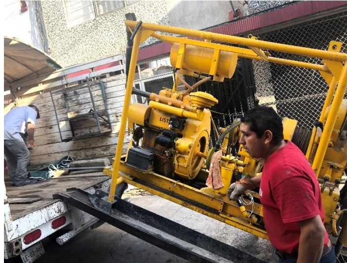
Imagen 18. Descarga de perforadora de pozos.
