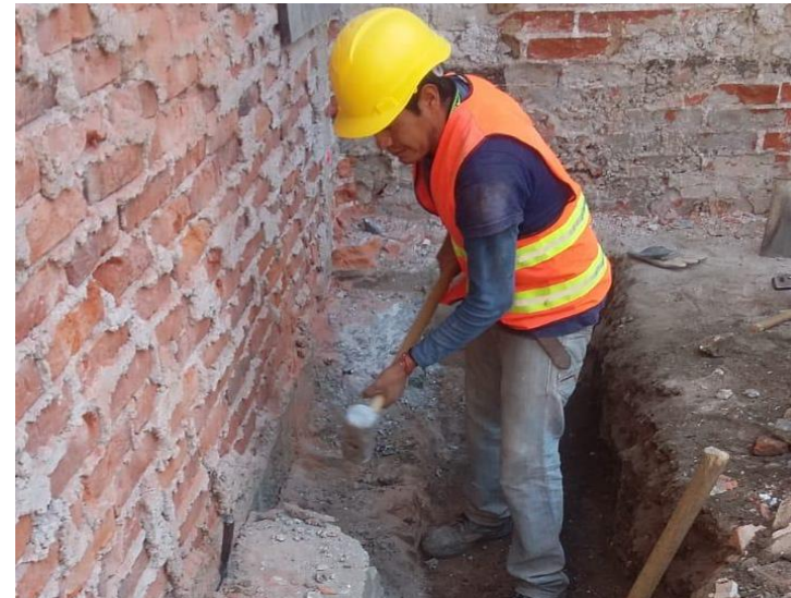
Imagen 32. Demolición de dala de desplante.
