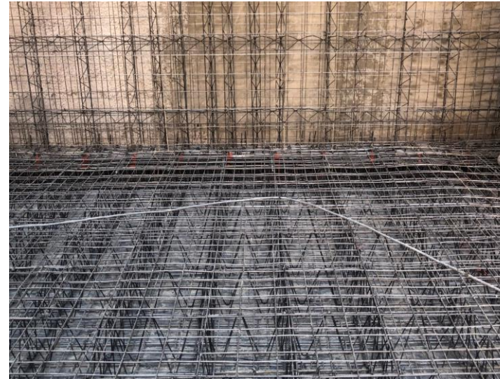
Imagen 37. Vista del armado de losa final
