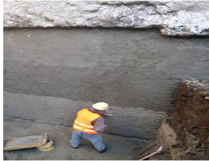
Imagen 06. Zarpeo, para dar paso al tabla estacado.
