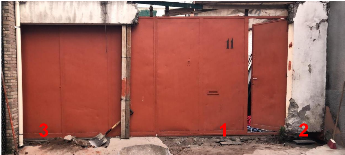
Imagen 06. Así se empezó a colocar las bases de acero.
