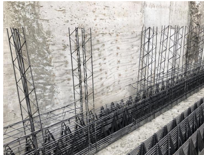
Imagen 16. Armado de muro colindante
