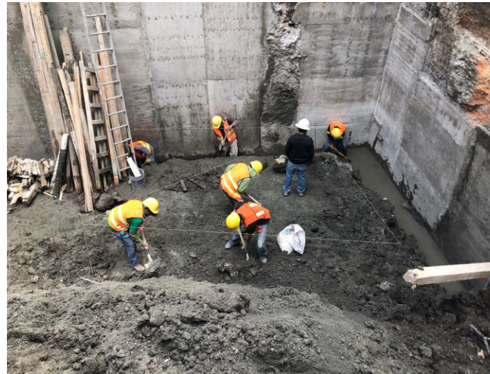
Imagen 03. Afine de tierra y poligonal marcada
