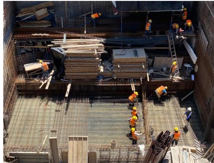
Imagen 74. Vista aérea de la obra, en proceso de armado de losa.
