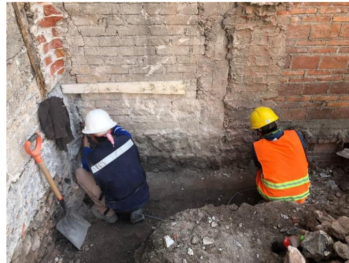
Imagen 02. Colocación de banco de nivel en el terreno.
