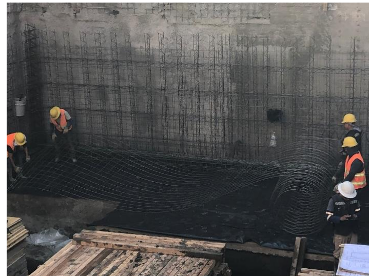
Imagen 34. Colocación de la malla estructural.
