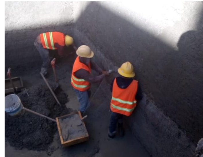
Imagen 07. Colocación de malla gallinero.
