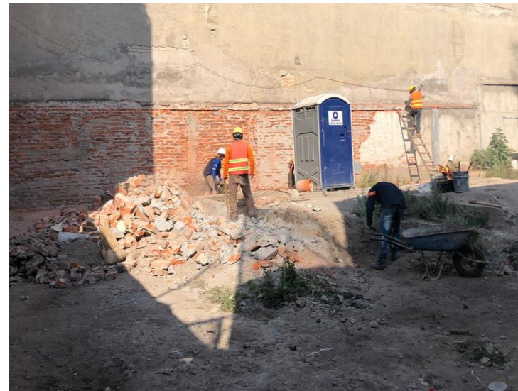
Imagen 20. Avance en la demolición.
