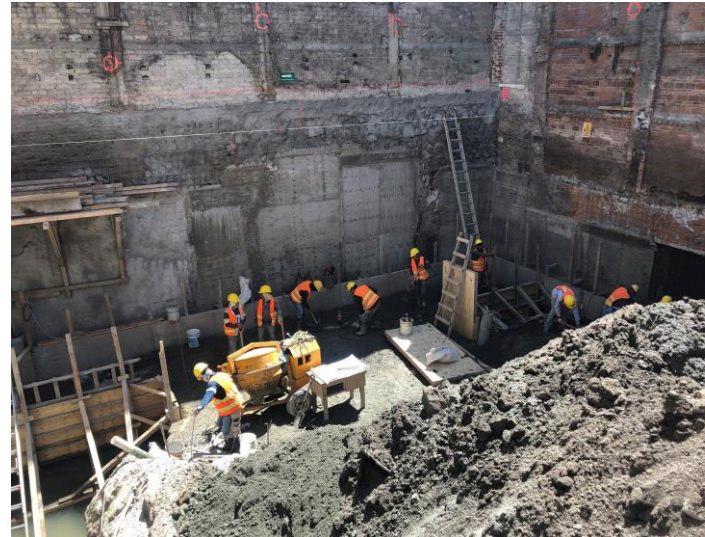
Imagen 07. Cimbrando para colar plantilla y plantilla de CCT
