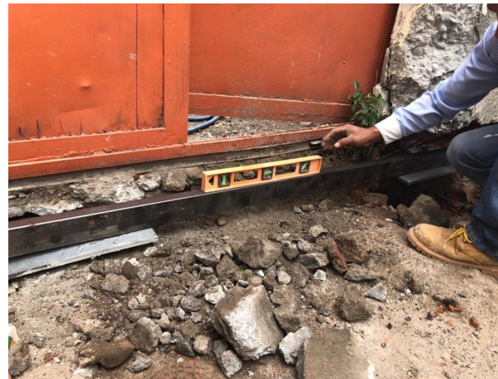
Imagen 05. Nivelamiento de placa
