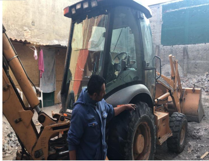
Imagen 12. Llegada de la excavadora .
