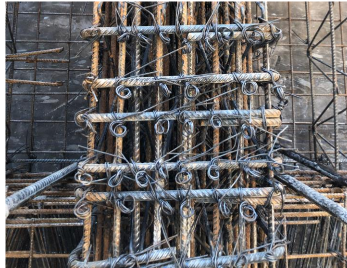
Imagen 84. Vista frontal del armado de la columna del eje G.
