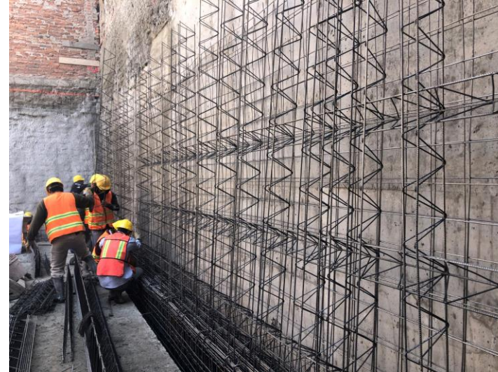
Imagen 18. Proceso de muro tridicel 3000.
