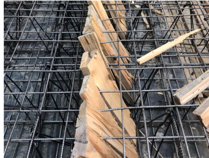
Imagen 39. Frontera 45° con astillas de madera.
