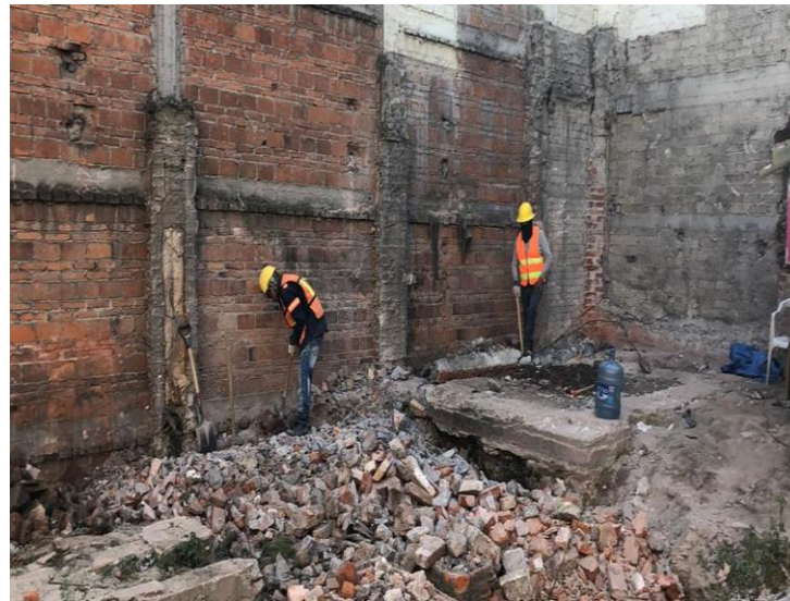
Imagen 22. Desmantelando dala de desplante.
