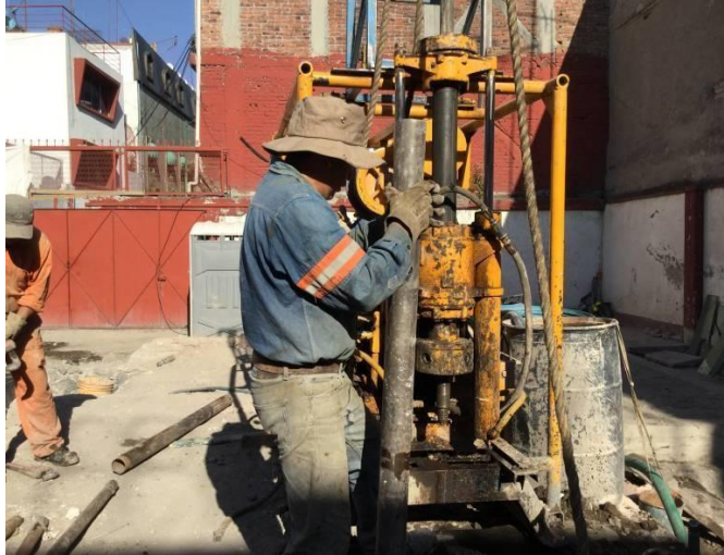
Imagen 05. Posicionamiento del segundo pozo
