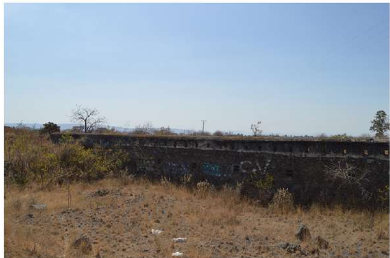
Fig. 45.- Representación de Tlasisco en el mapa no. 845 y elemento arquitectónico ubicado en la misma área en recorridos de campo. Fotografía del autor.
