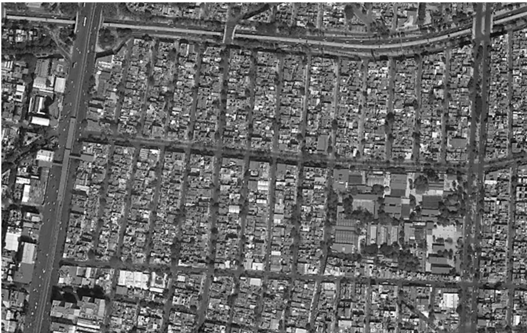
Fuente: Google Earth, vuelo 2.11.2017, altura 3.5 km Fraccionamiento Viducto Piedad, núcleo urbano
