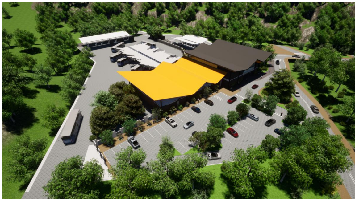
ESTACIONAMIENTO – ANDENES DE AUTOBUSES
