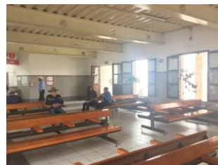
(4) Sala de espera de espera, mobiliario insuficiente e inadecuado.
