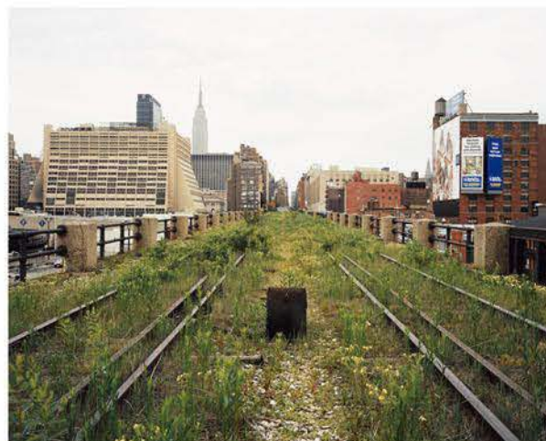
Imagen 23. Estado previo a High Line Park, NYC
