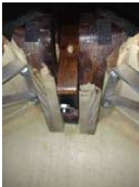
Fig. 2. Refuerzos en bloque superior y sistema giratorio vista interna.
