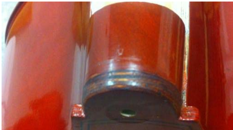
Fig. 33. Detalle de reforzamiento de lengüeta.
