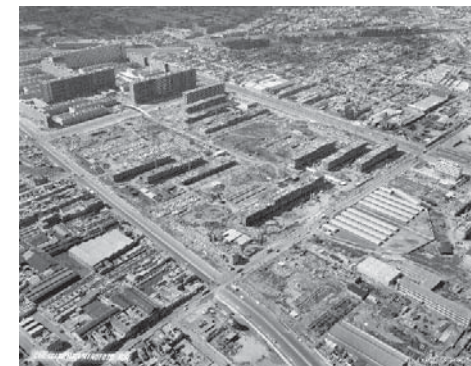
CONSTRUCCION CIUDAD TLATELOLCO
