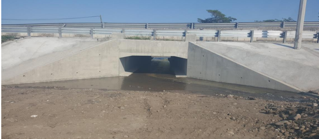
Figura 5.7 (m) Alero de la alcantarilla P.S.V. San Isidro, fuente cortesía de la empresa Freyssinet de México.
