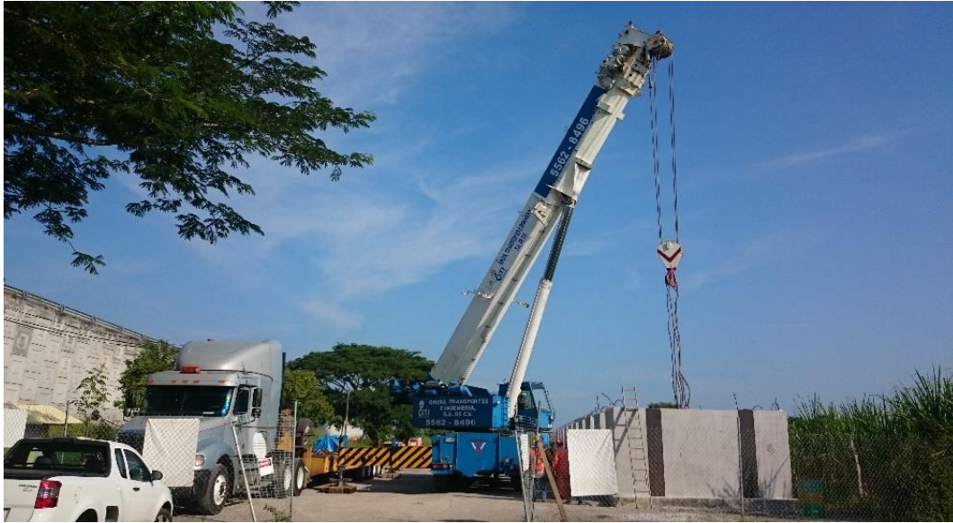
Figura 5.4. (e) Transporte de movimiento de Cajones Techspan de patio de fabricación a lugar de reforzamiento de la alcantarilla. fuente obtenida por la empresa Freyssinet de México
