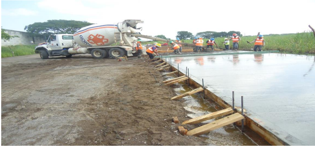
Figura 5.1 (a) Patio de fabricación de los Cajones Techspan. fuente obtenida por la empresa Freyssinet de México
