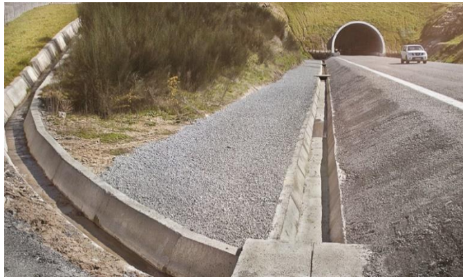
Figura: 2.4.(b). Drenaje longitudinal, Fuente obtenida por la página
