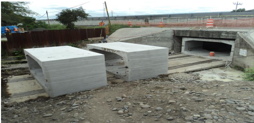
Figura 5.5 (h) Autoripage de Cajones Techspan con el sistema patentado de la empresa Freyssinet de México
