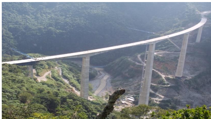
Fig. 2.4.(h) Puente San marcos Cdmx-Tuxpan. Cortesía Freyssinet de México
