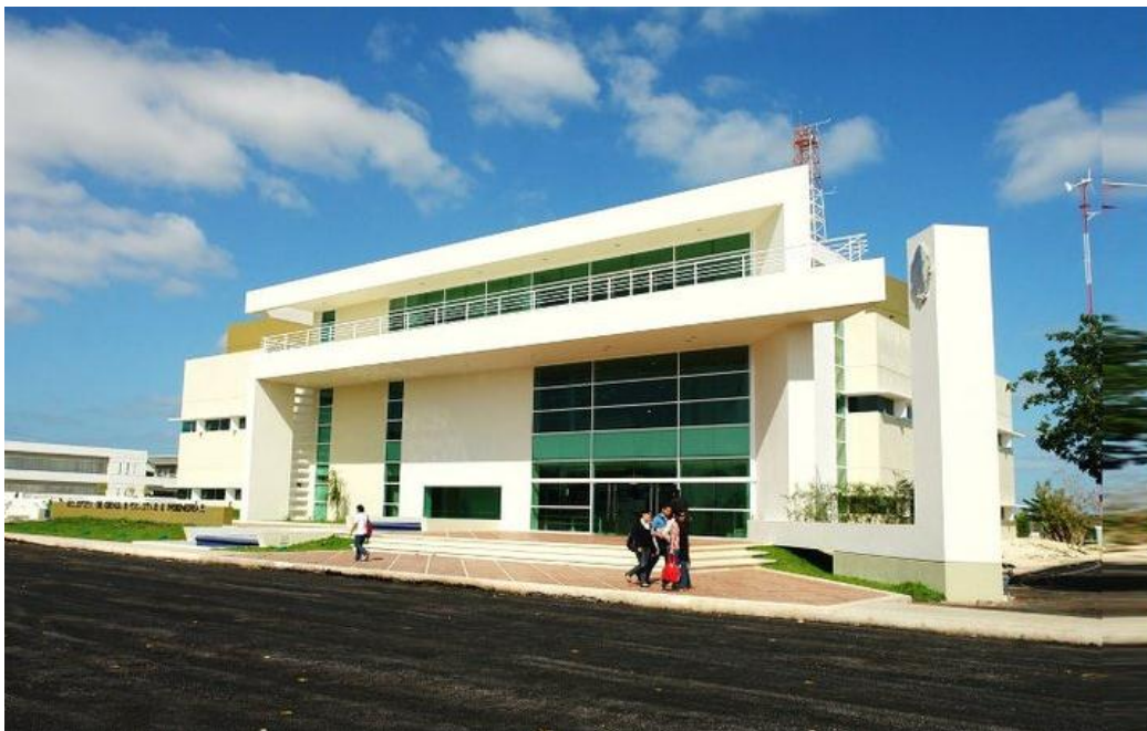
Figura 88. Al fondo a la izquierda, se pueden apreciar los edificios de la Facultad de Ingeniería y Ciencias Exactas de solo 2 pisos, que rodean a la biblioteca de tres pisos ubicada al centro de esta misma imagen (Fuente: UADY, Sistema Bibliotecario, http://www.bibliotecas.uady.mx/img/galeria/inge/185930_138472122886326_6718959_n.jpg ).
