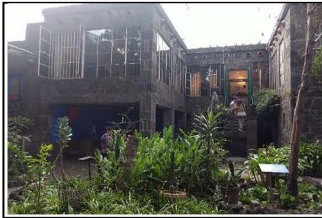
T2. FACHADA CASA-ESTUDIO
