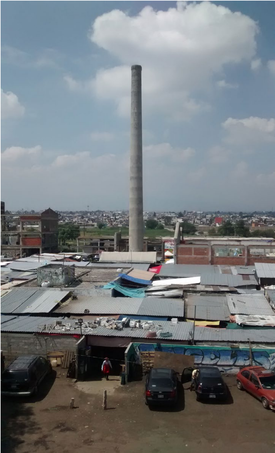
Foto 08: Vista chimenea, fotografía: Propia
