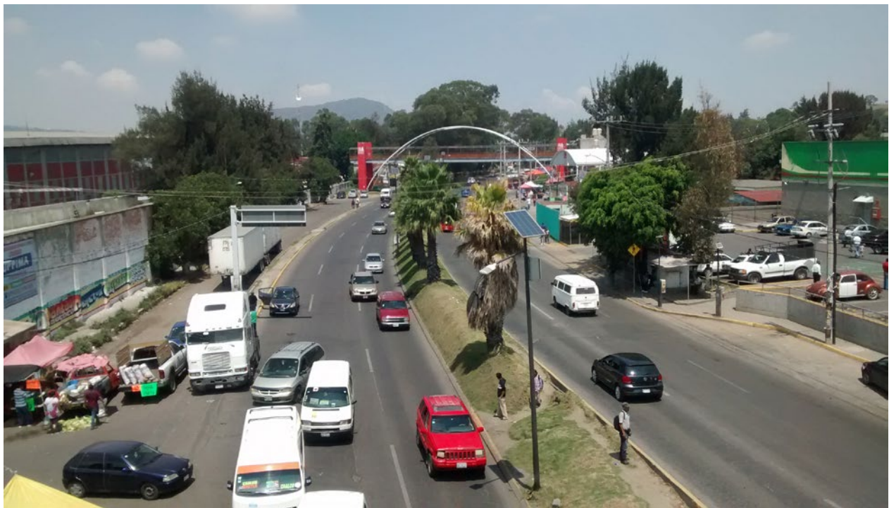
Foto 02: Carretera Federal México-Puebla, fotografía: Propia
