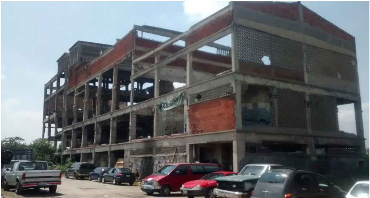
Foto 10: Edificio existente (abandonado), fotografía: Propia
