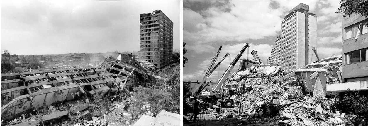
Figura 9a y 9b. Daños materiales en infraestructura y servicios públicos: sismo de 1985
