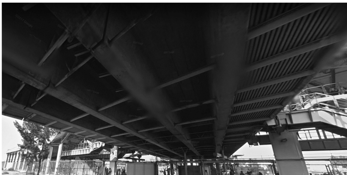
FIGURA III.17. Vista frontal en campo que muestra los elementos secundarios (tubos) para rigidizar los elementos primarios (vigas cajón) del Puente Impulsora.
