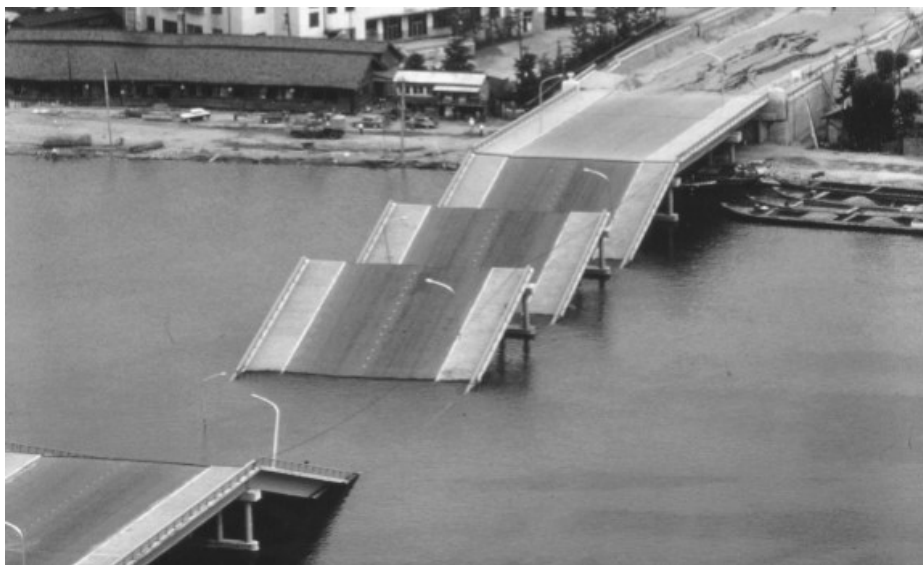
FIGURA II.11.- Colapso del Puente Showa, terremoto de 1964, Niigata (Wai-Fah & Lian, 2003)
