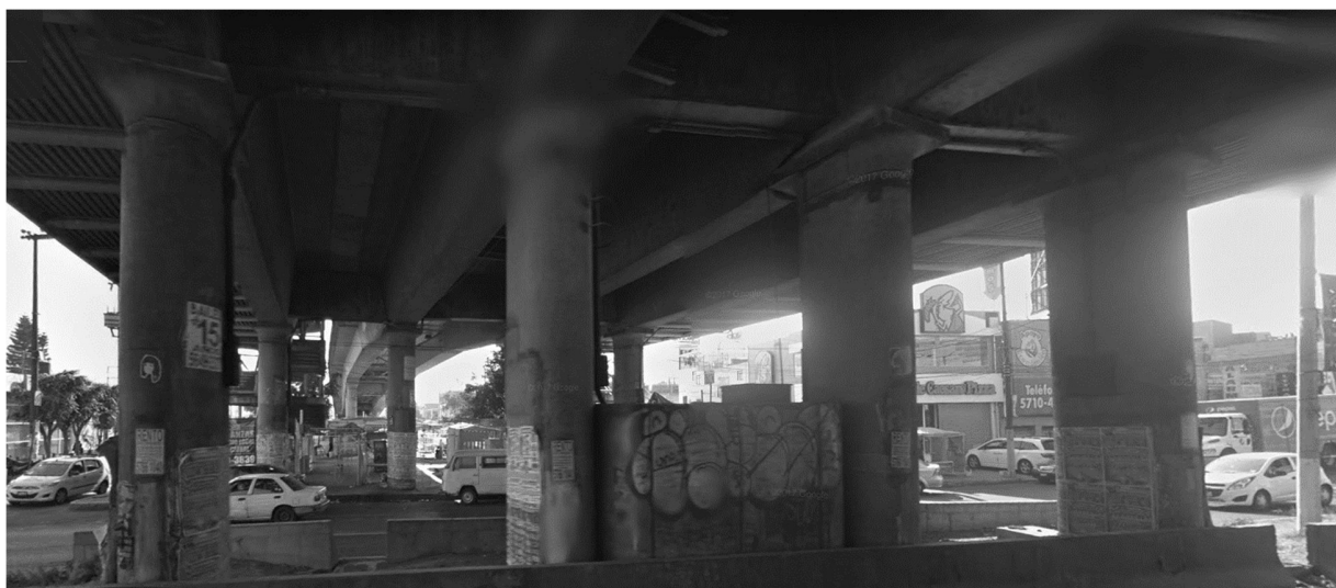
FIGURA III.13. Vista frontal actual de disposición estructural, en campo, de los elementos de subestructura del apoyo instrumentado del Puente Impulsora.
