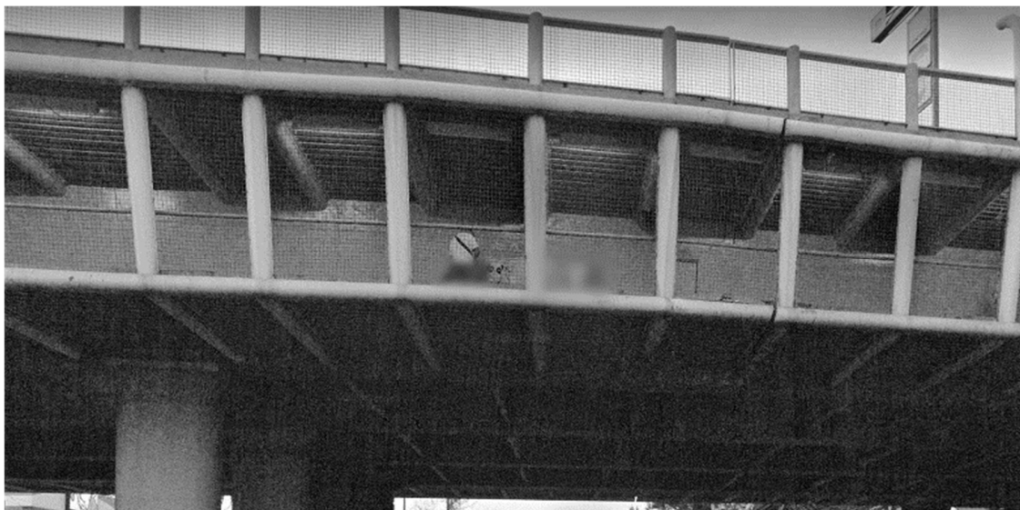
FIGURA III.18. Vista lateral en campo que muestra los elementos de soporte del tramo volado de la cubierta del Puente Impulsora.
