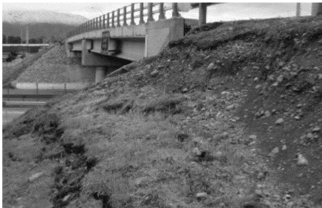
FIGURA II.22. Movimiento en terraplén de estribo en el Puente La Punta (Schexnayder, et al., 2014).
