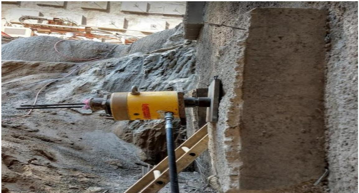
*Ilustración 12. Tensado de ancla activa.*
