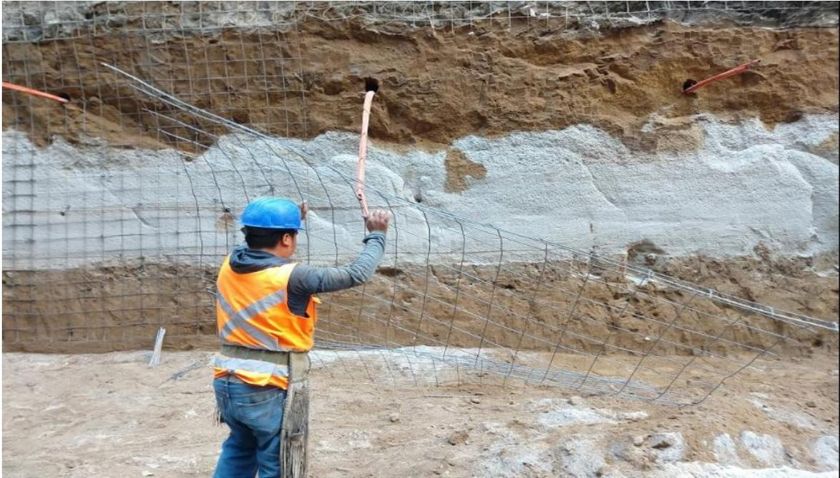
Fotografía 12. Colocación de malla electrosoldada.
