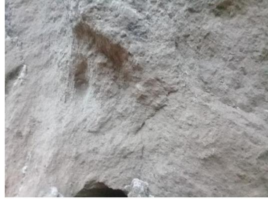
Fotografías C y D: Se observa como inicia el desprendimiento del material del talud.
