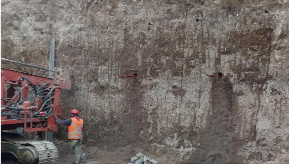
*Fotografía 1. Colocación de un hilo para pasar el nivel de las perforaciones y proceder a barrenar.*
