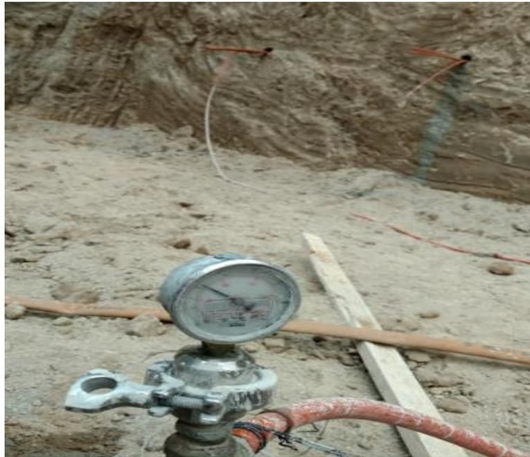
*Fotografía 3. Inyección de lechada a 2 kg/cm<sup>2</sup> y al fondo se aprecia el barreno en el que se aplica la lechada, se aprecia que los barrenos no tienen un obturador y por lo cual se inyectan hasta que la lechada sale por el barreno.*
