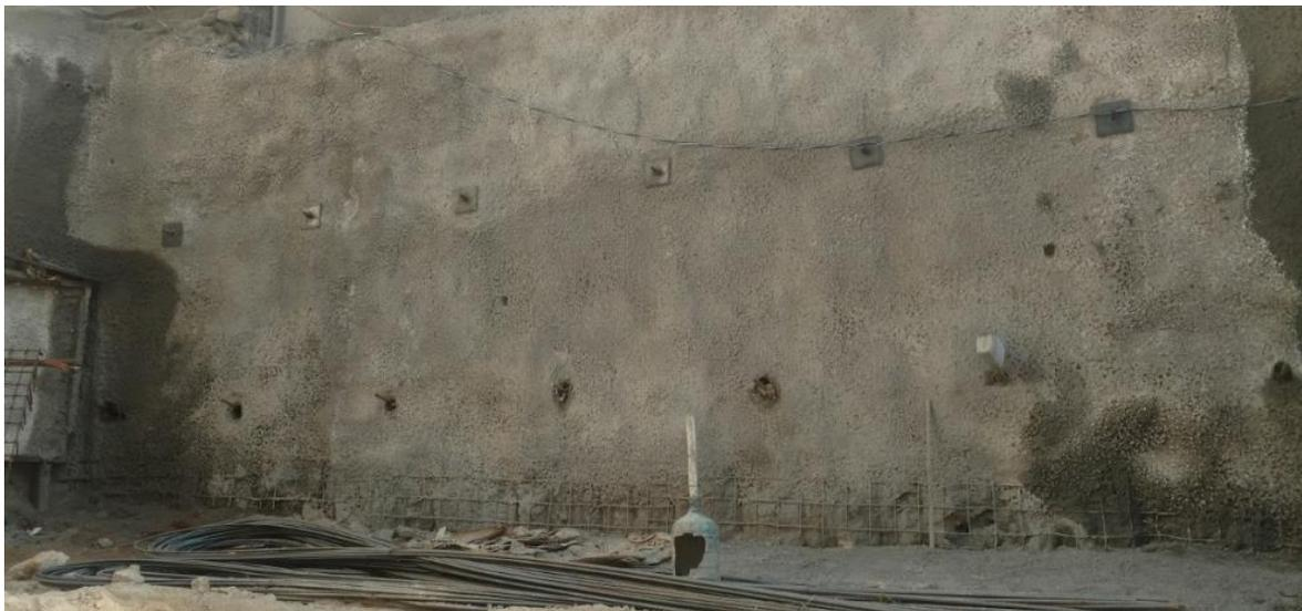
*Fotografía 4. Aplicación de lechada de inyección a gravedad, contrario a lo que indica en el estudio.*
