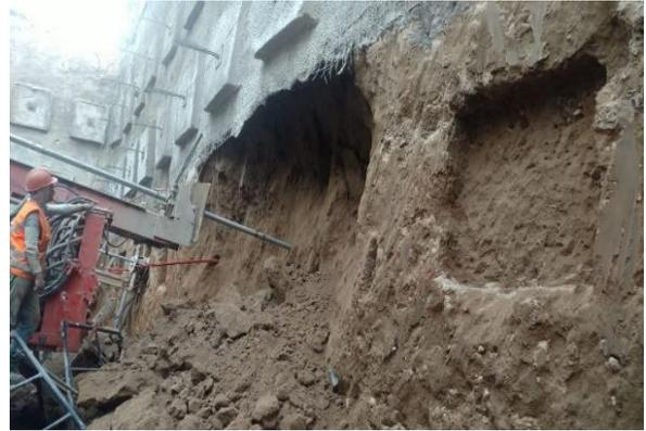
Fotografías E y F. Se observa la ubicación del equipo de perforación próximo a la zona de deslizamiento y el equipo de perforación que se encontraba en la zona perforando en dicha zona, ambos se encontraban trabajando simultáneamente.
