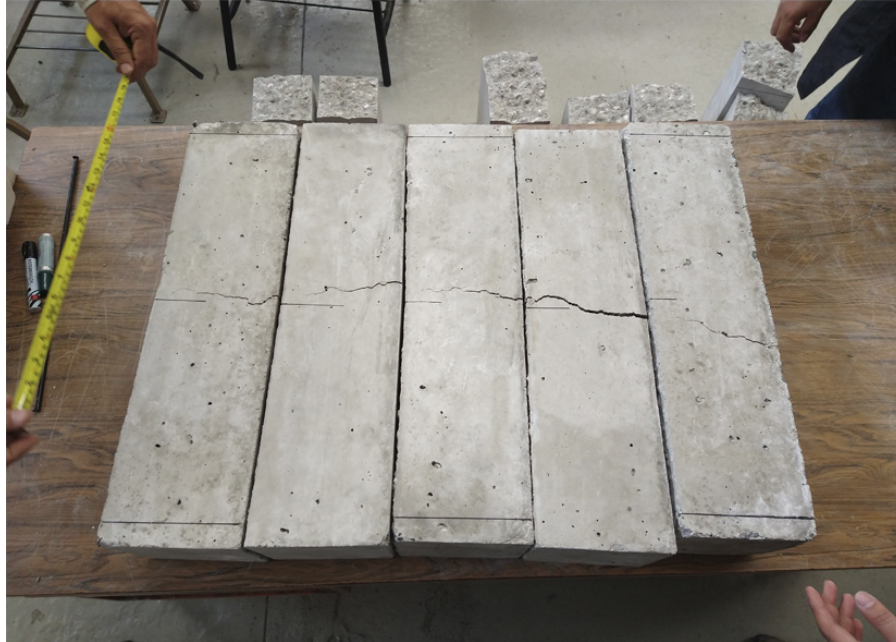
Figura 4.12: Fracturas en vigas de CCF.
