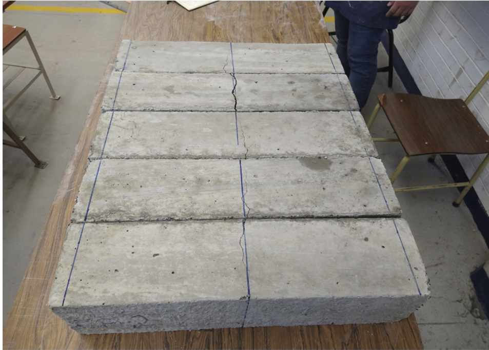
Figura 4.13: Fracturas en vigas de CCG.
