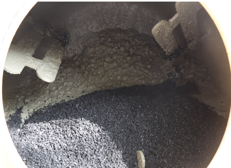
Figura 3.8: Proceso de mezclado del caucho en el concreto.
