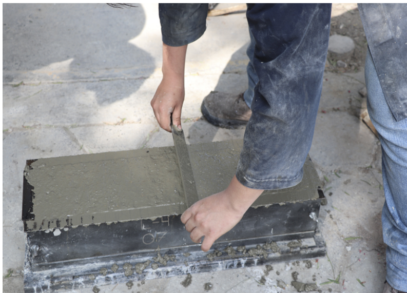
Figura 3.12: Enrasado del concreto.
