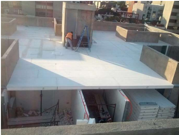
Ilustración 19. Colocación de MagPanel. Fuente: magtec
