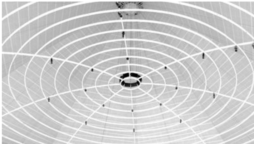
La estructura del domo vista desde adentro del semaxané .
