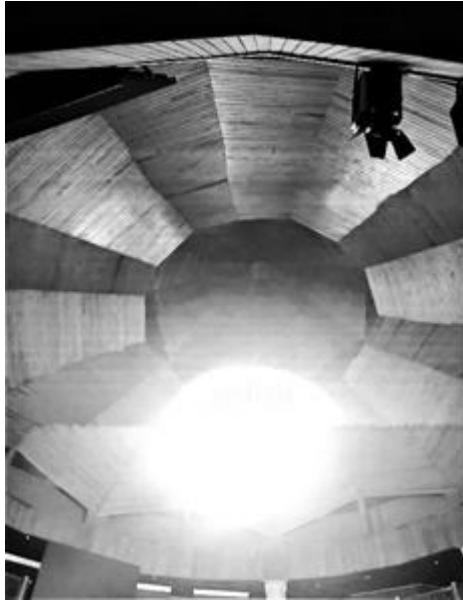
Estructura octagonal del domo del semaxané del Centro de Investigación de las Civilizaciones IRFA, Konya. El domo se compone de ocho vértices, al igual que el remate.
