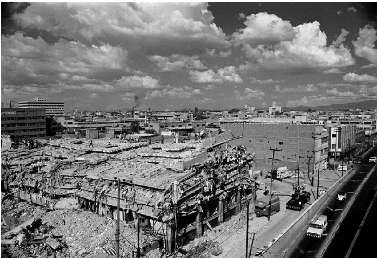
Foto: Vista general del edificio donde se encontraban talleres ilegales de costura en San Antonio Abad. Terremoto de 1985. Ciudad de México. Cuartoscuro, Pedro Valtierra.
