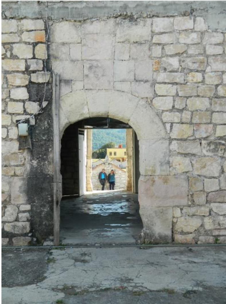
Acceso principal Casa del Pueblo Imagen: Diana Méndez. Diciembre 2018
