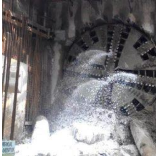
Figura 23.- Llegada de TBM a lumbreira. Recuperado de www.normet.com .
